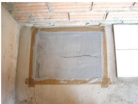
Aplicación de resinas en M IV-6PU75A
