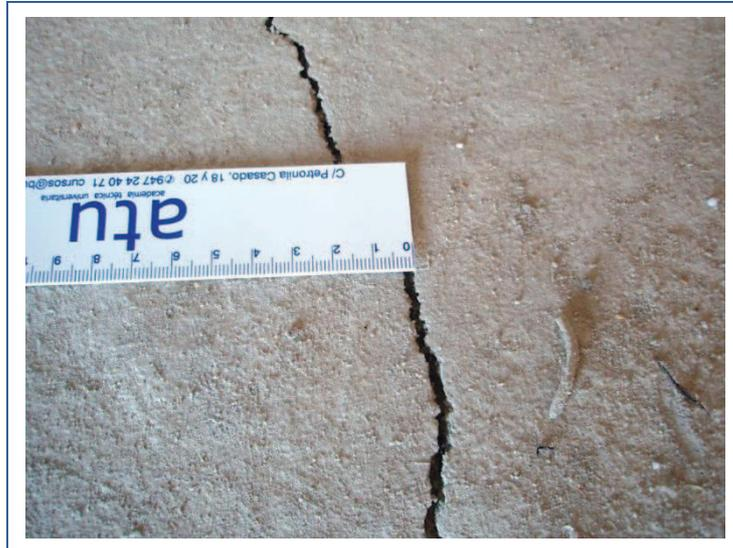
**Figura 7.3.** Anchura de fisura 2,5 mm. Mortero en solado M IV-6PU75A
