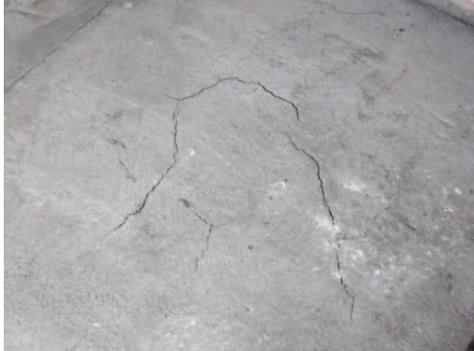
Fisuras por retracción a las 24 horas
