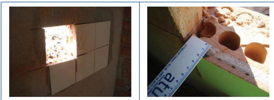
Figura 7.6. Extracción testigo
