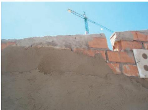
Se aprecian las dos capas de enfoscado
