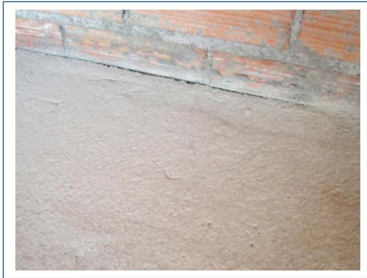
**Figura 7.5.** No existen aplastamientos localizados en los morteros de suelo
