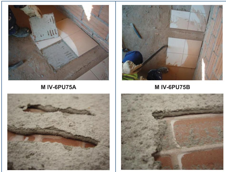
Figura 7.9. Buena adhesión del adhesivo al mortero de solera
