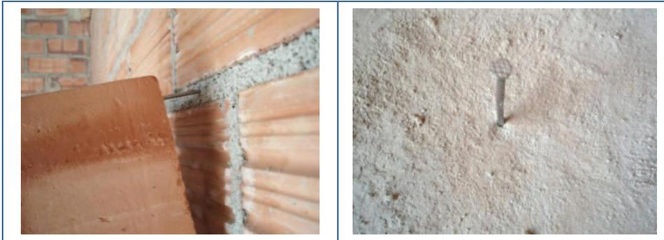
**Figura 7.12. Mortero de juntas****Mortero de solera**
