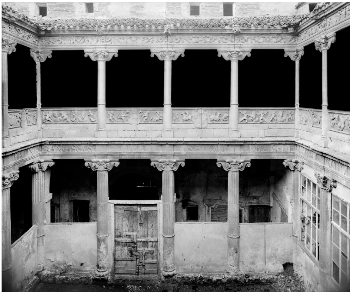
Figura 144. Patrio de la Casa Miranda antes de su restauración. AMBu, FO-1359.
