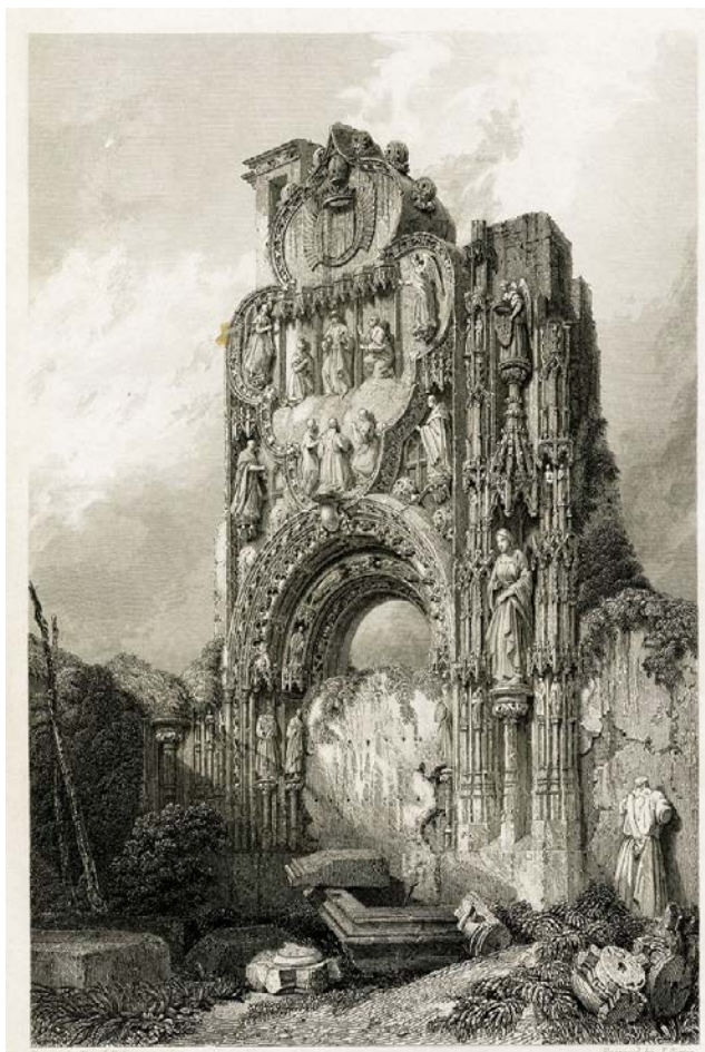
Figura 14. Ruinas del Convento de la Trinidad. Burgos. D. Roberts. 181? AMBu, FO-25502.
