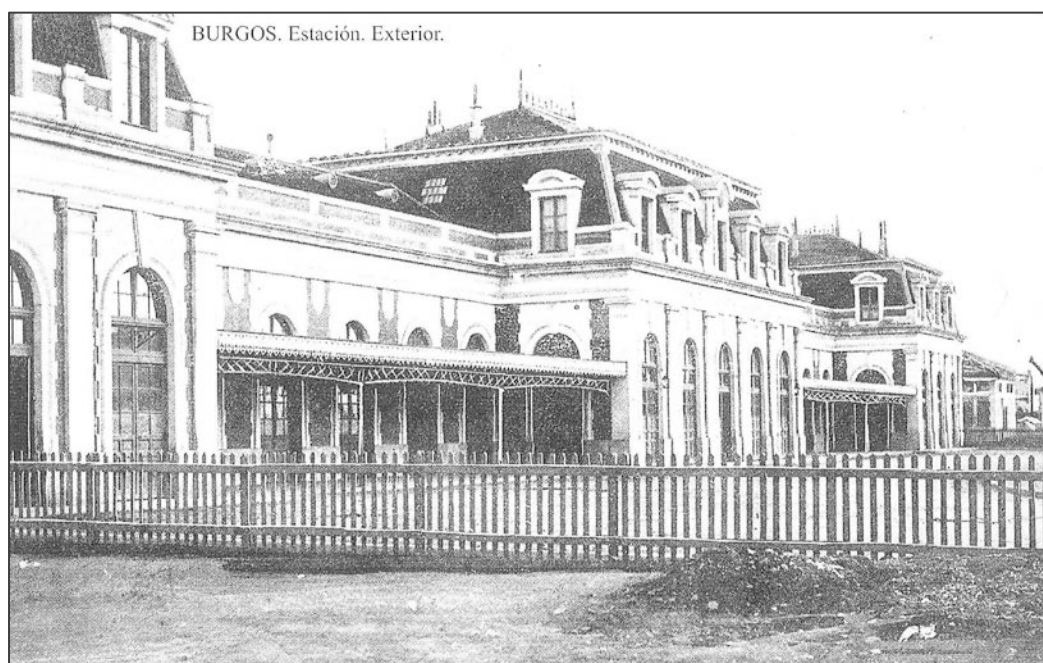
Figura 81. Exterior de la estación de ferrocarril en 1910, aproximadamente. Col. particular.
