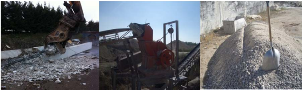
Figura 4.4: Proceso de obtención del árido reciclado de hormigón.
