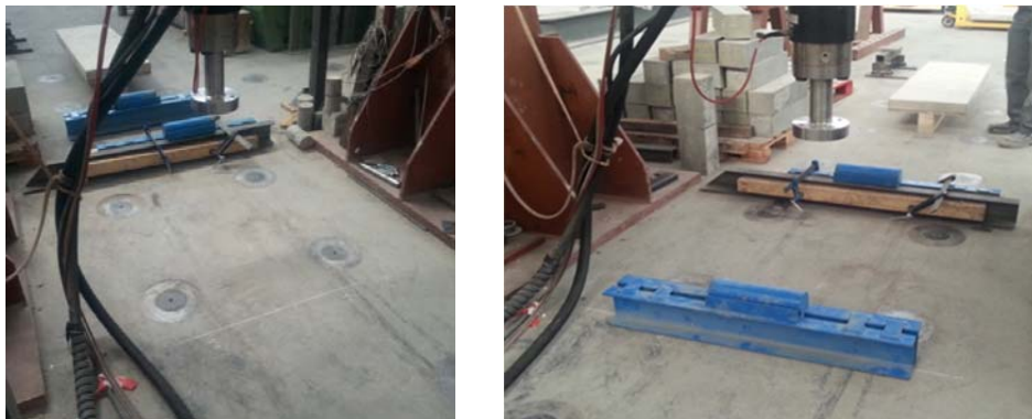
Figura 6.11: Replanteo y posicionamiento de los soportes.
