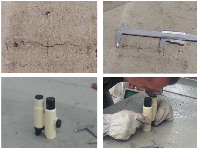
Figura 6.7: Fisura y medición de la evolución de la misma.
