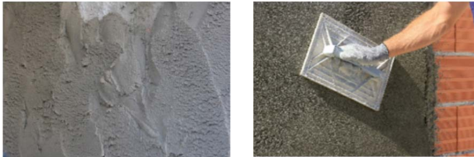
Figura 3.3: Aplicación de mortero de corcho. Fuente: www.cannabric.com .
