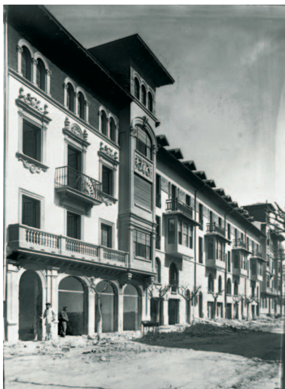
153. Alfonso Vadillo, Viviendas construidas entre las calles Barrantes y Aparicio Ruiz , ca. 1928. AMBu, FO-1537
