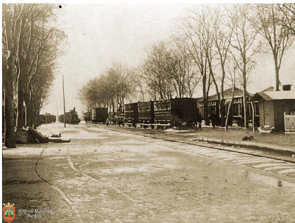
005. Juan Antonio Cortés, Instalaciones ferroviarias . AMBu, FC-2702
