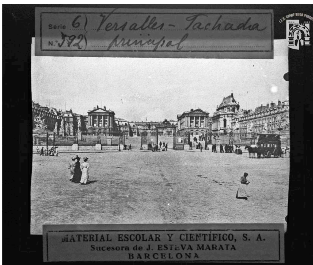
102. Versailles. Fachada principal. FFICDP
