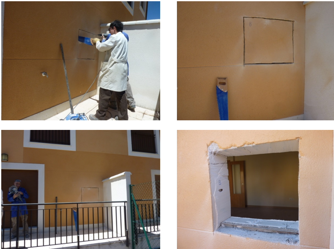
Fig. 2 Extracción de bloque de fachada para la elaboración de muestras de mortero in situ .
