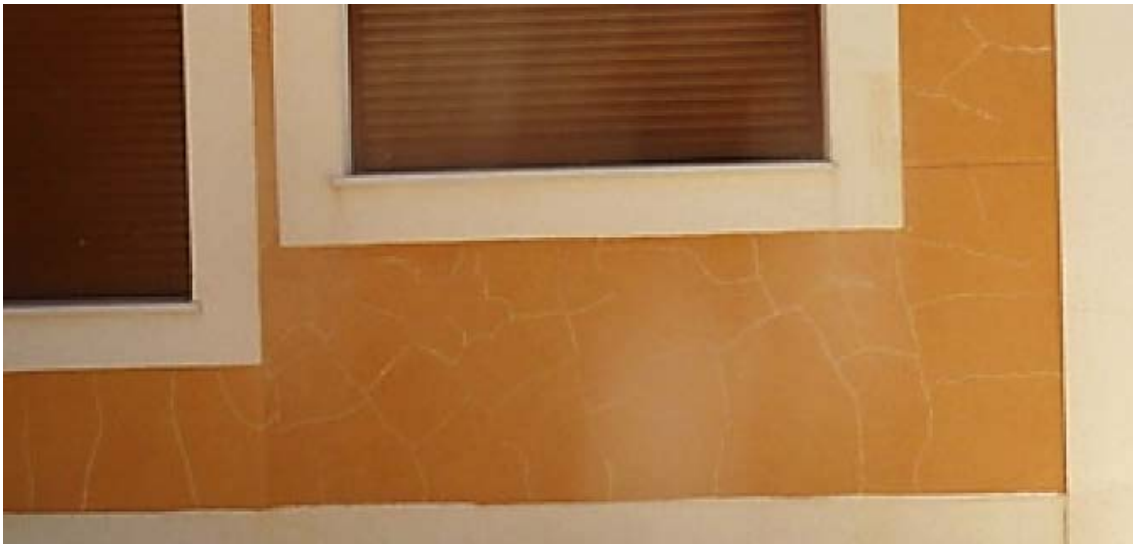
Fig. 1 Detalle de fisuración del mortero de revestimiento.
