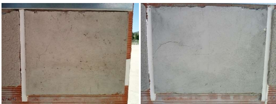
Figura 8.4 Puesta en obra. Revestimiento CH40LF+1/3MB600 (izquierda) y BAS-C-LF+1/3MB600 (derecha). Julio 2017.
