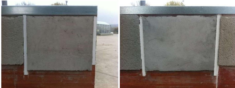
Figura 8.2 Puesta en obra. Enfoscado CH40LF+1/3MB600 (izquierda) y BAS-C-LF+1/3MB600 (derecha). Enero 2017.
