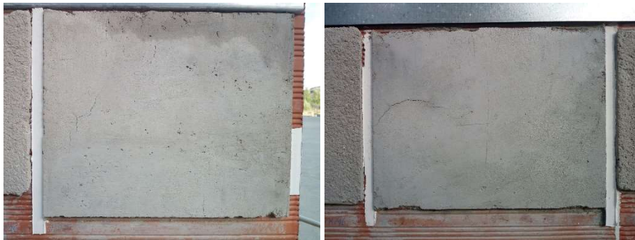
Figura 8.5 Puesta en obra. Revestimiento CH40LF+1/3MB600 (izquierda) y BAS-C-LF+1/3MB600 (derecha). Octubre 2017.
