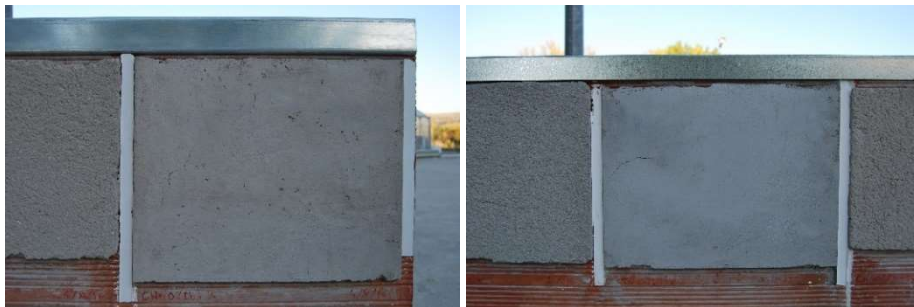
Figura 8.3 Puesta en obra. Revestimiento CH40LF+1/3MB600 (izquierda) y BAS-C-LF+1/3MB600 (derecha). Abril 2017.
