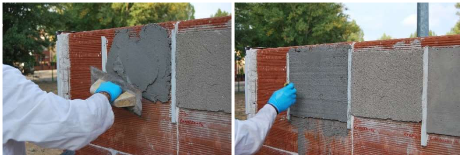
Figura 8.1 Realización del enfoscado vertical. Octubre 2016.
