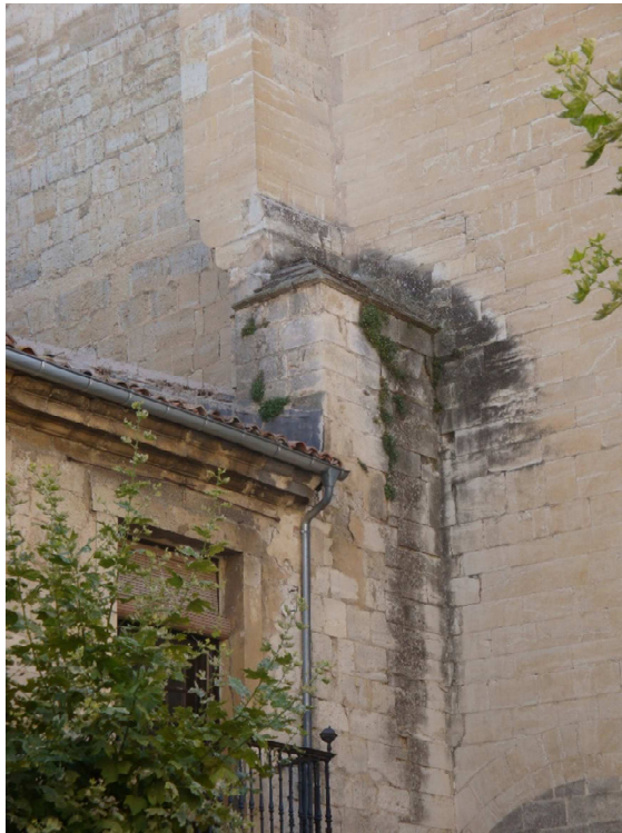
102 Contrafuerte con humedad y vegetación en la iglesia del convento de Santa Clara (Briviesca, Burgos). Fotografía de la autora.
