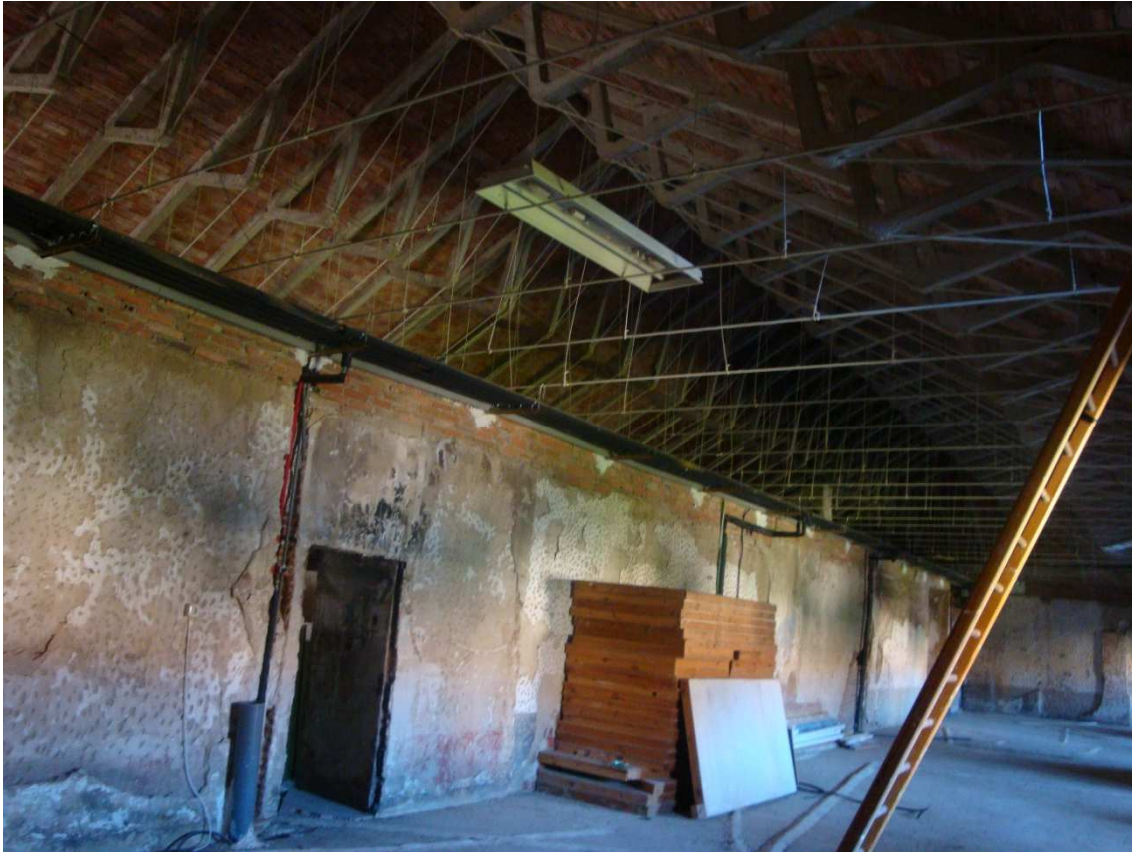
95 Planta superior de la casa arrasada por un incendio
