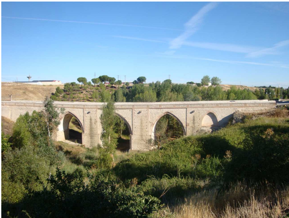
126 Vista general del puente de Medina (Arévalo, Ávila). Fotografía de la autora
