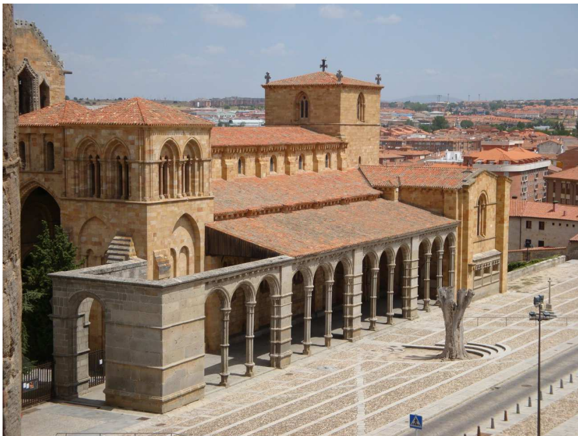
14 Vista desde las murallas del pórtico que pudo ser eliminado en las restauraciones del siglo XIX de la basílica de los Santos Mártires Vicente, Sabina y Cristeta (Ávila). Fotografía de la autora
