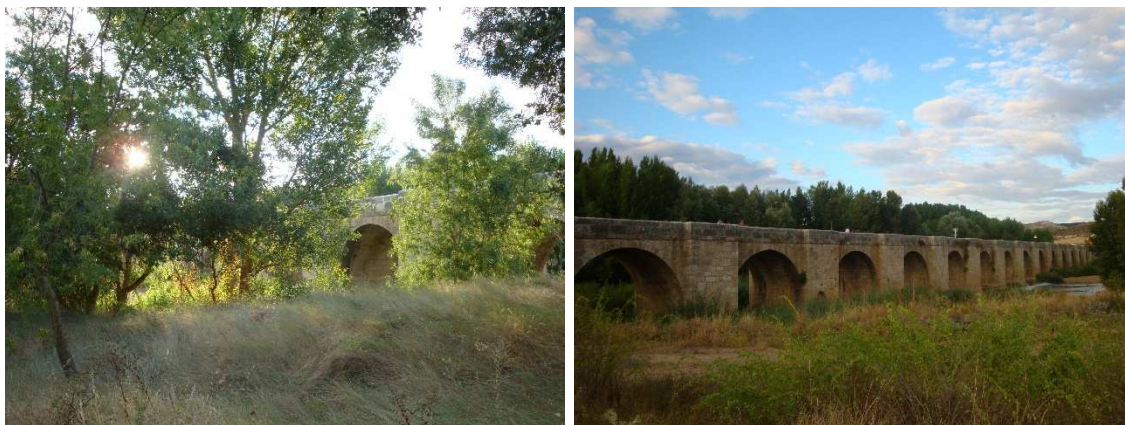
71 Vista del puente (Cordovilla la Real, Palencia) (I). Fotografía de la autora
