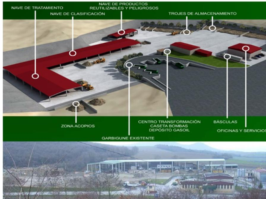
Fig. 12 Esquema planta de tratamiento de Vitoria. (Fuente cortesía UTE Gardelegui).
