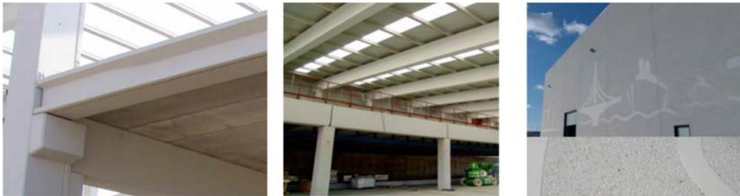
*Fig. 22 Elementos prefabricados de vigas, pilares y forjados (foto izquierda), elementos prefabricados de cubiertas de gran luz (foto centro) y paneles prefabricados de naves (foto derecha).*
