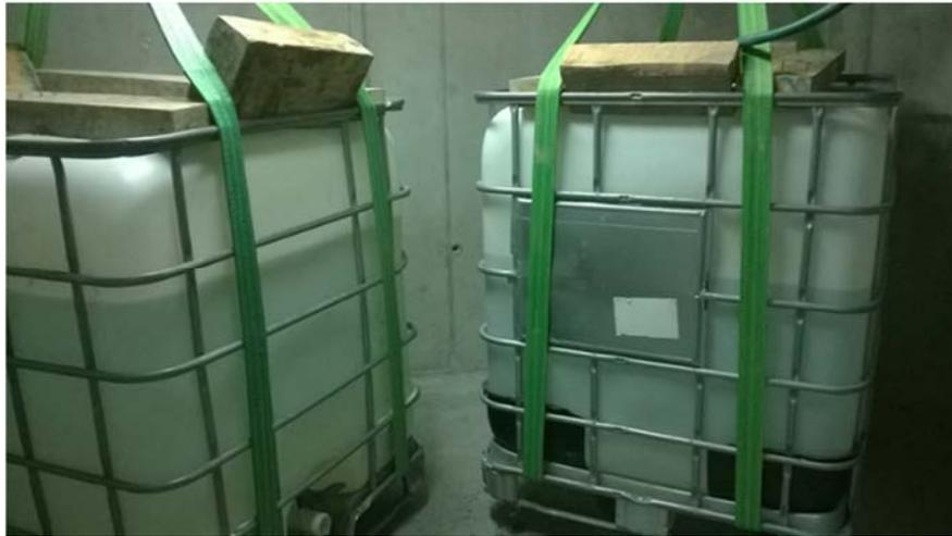
Fig. 230 Llenado depósitos de manera gradual para evitar desplomes.
