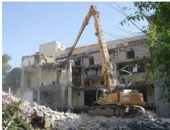
*Fig. 2 Demolición de un edificio con estructura de hormigón.*
