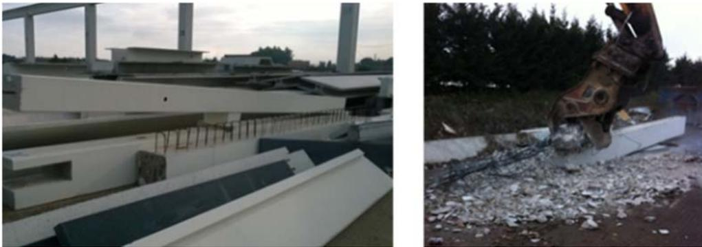
Fig. 25 Pinza hidráulica utilizada para eliminar armaduras y extraer los residuos de tamaño aproximadamente de hasta 150 mm para procesar en machacadora.
