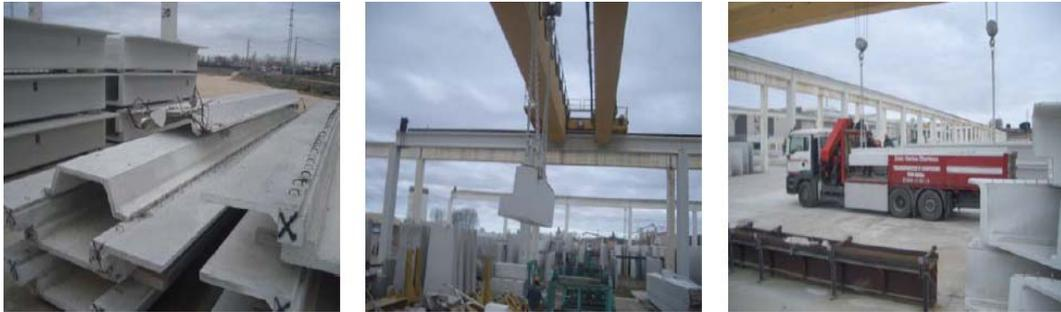
Fig. 24 Transporte a la planta de residuos para su trituración.
