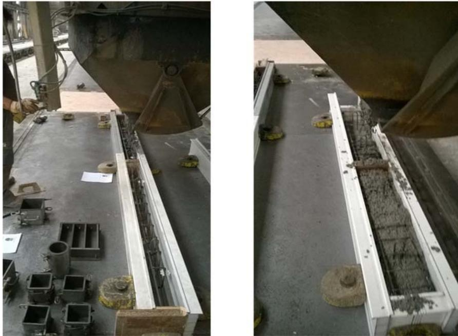
Fig. 219 Hormigonado mediante cubilote de capacidad 1 m<sup>3</sup> y apertura de la boca hidráulica.
