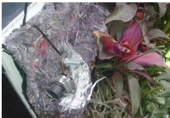
Ilustración 11: Sistema de filtros según tipología patentada por Patrick Blanc
