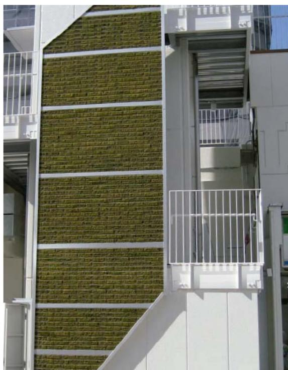
Ilustración 33: Ejemplo de sistema Geo-moss instalado, fuente Geobois
