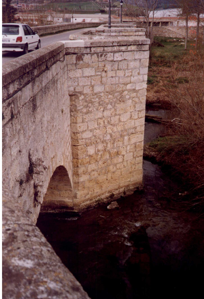
Ilustración 224. Foto de detalle de recrecido de tajamares en pila nº 4 del puente en Villamuriel de Cerrato.
