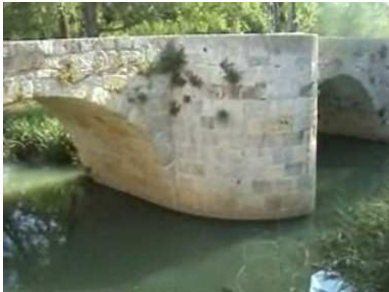
Ilustración 193. Foto de espólón semicircular en puente de Puentecillas.
