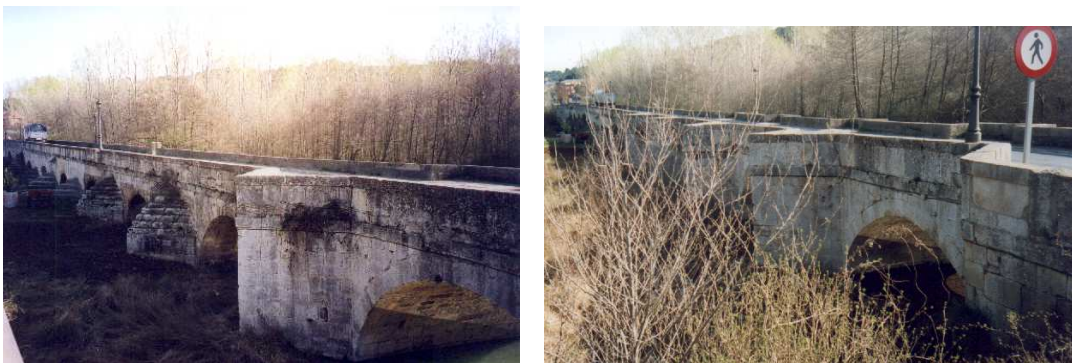
Ilustración 95. Foto de detalle de tajamares del puente en Saldaña.
