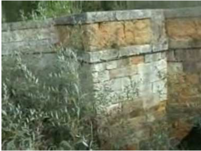
Ilustración 103. Foto de detalle de tajamar triangular, con diferentes procedencias de materiales en puente en Saldaña.
