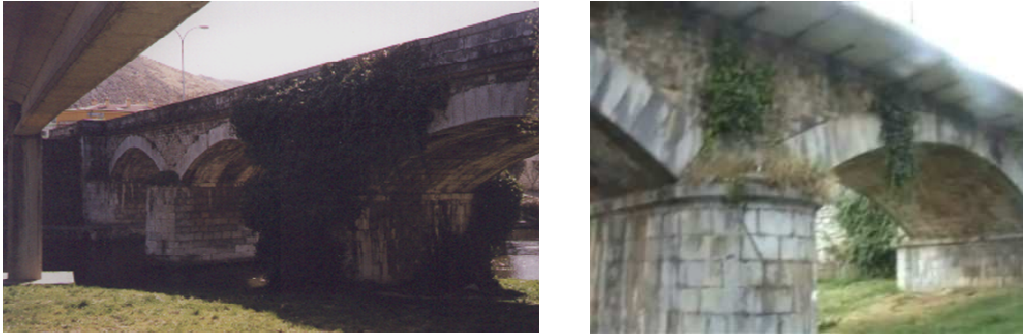
Ilustración 64. Fotos comparativas de su estado anterior a la ampliación y actual.
