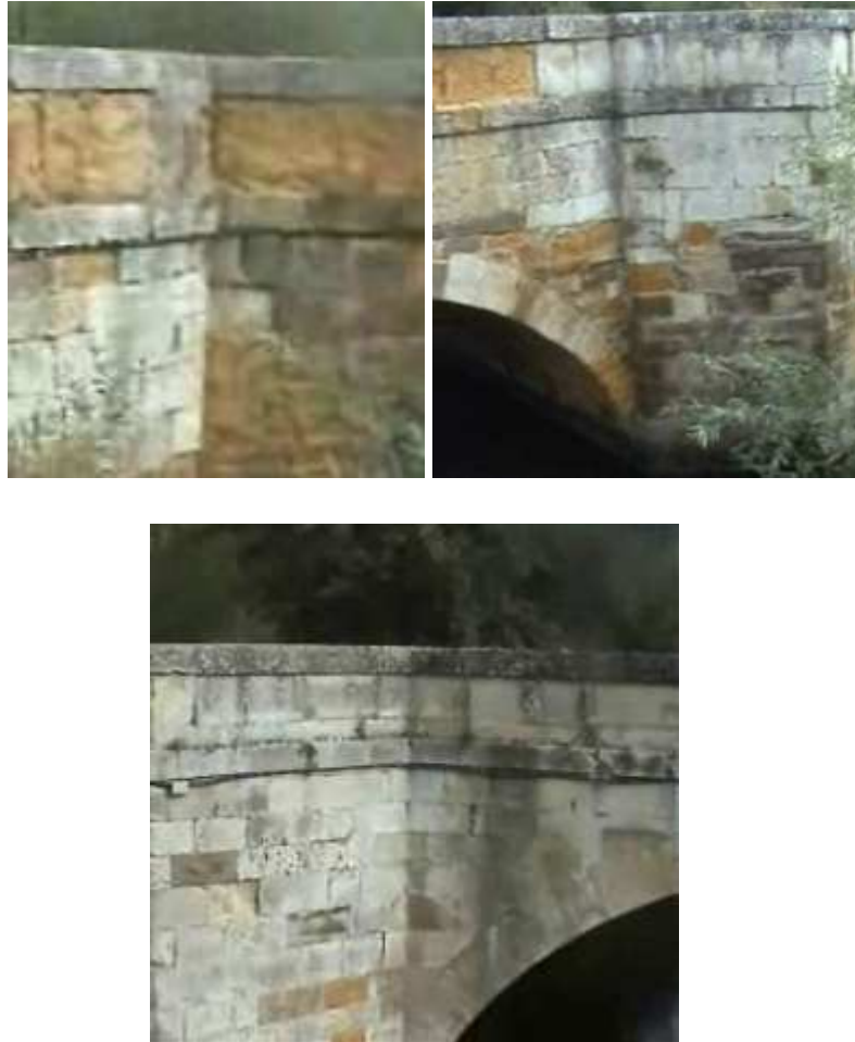
Ilustración 107. Fotos de detalle de la trabazón entre tajamares y tímpanos en puente en Saldaña.
