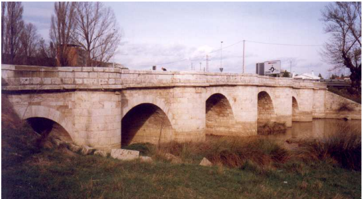
Ilustración 174. Foto de conjunto del puente de Don Guarín (aguas abajo).
