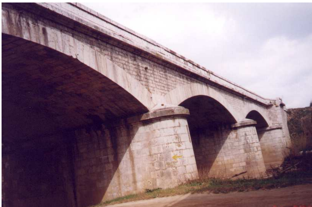
Ilustración 230. Foto de conjunto de puente de San Isidro en Dueñas.
