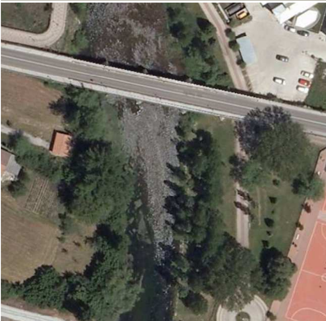
Ilustración 78. Vista aérea del puente en Guardo.
