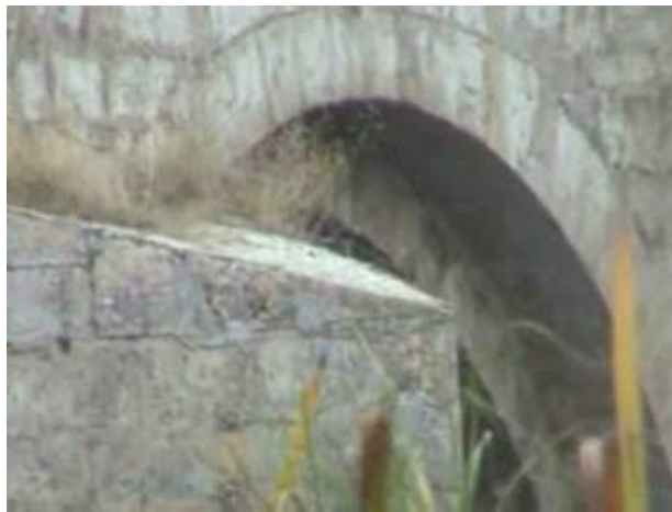
Ilustración 151. Foto de bóveda ensanchada en puente en Mozón de Campos.
