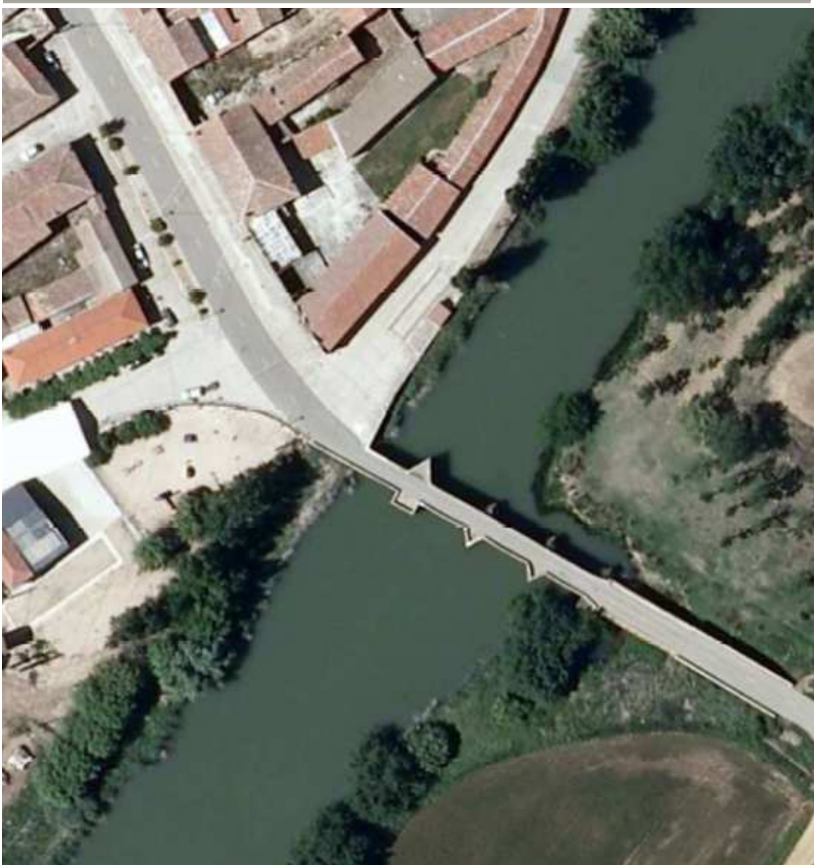
Ilustración 159. Vista aérea del puente en Husillos.
