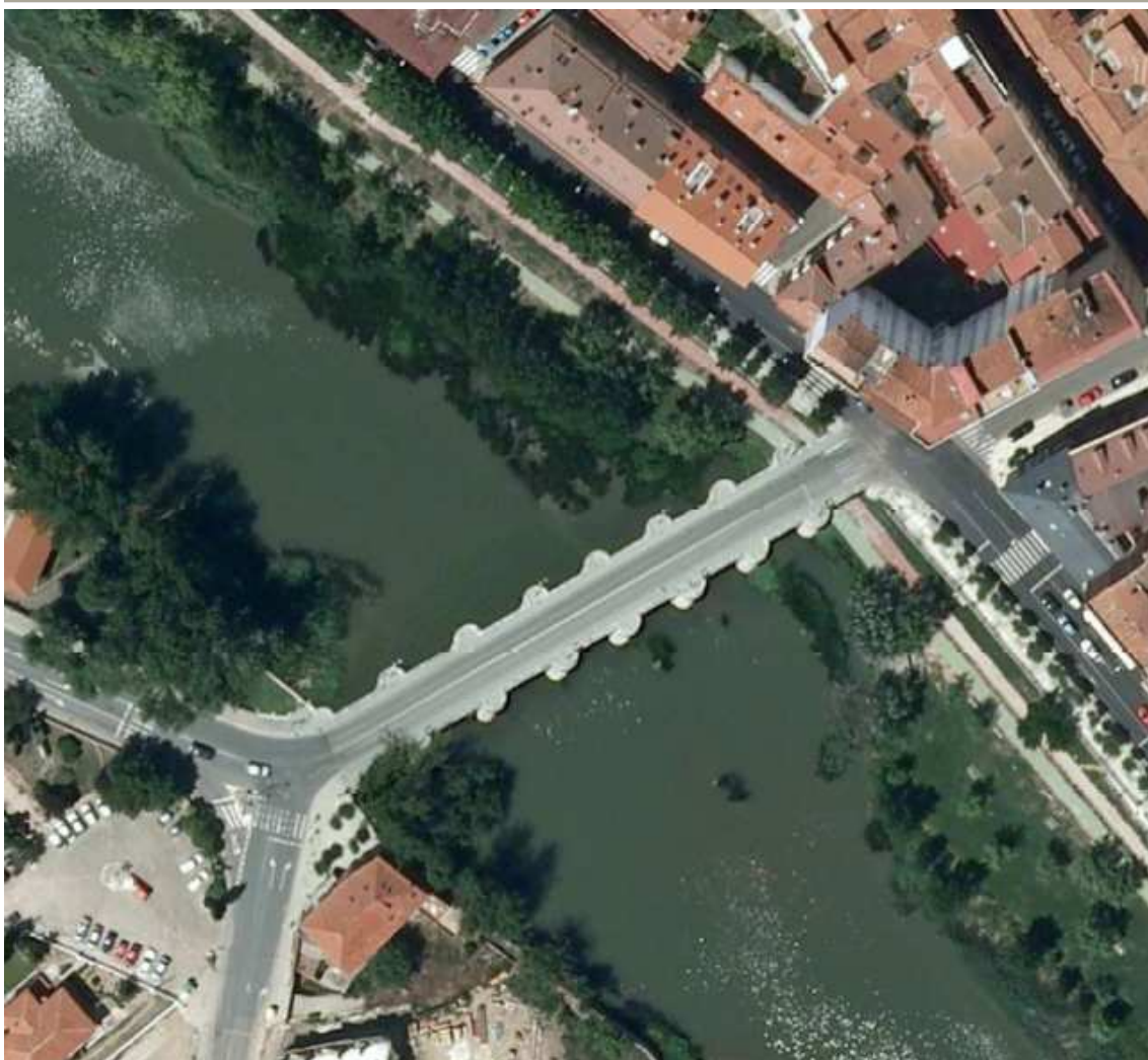
Ilustración 199. Vista aérea del puente Mayor.
