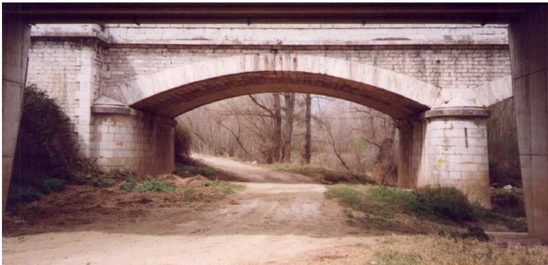
Ilustración 234. Foto de detalle de arco escarzano en puente de San Isidro en Dueñas.
