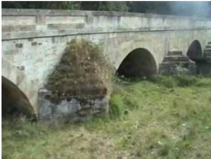
Ilustración 101. Foto de tajamares hasta línea de separación con bóveda, con diferentes sombreretes en puente en Saldaña.
