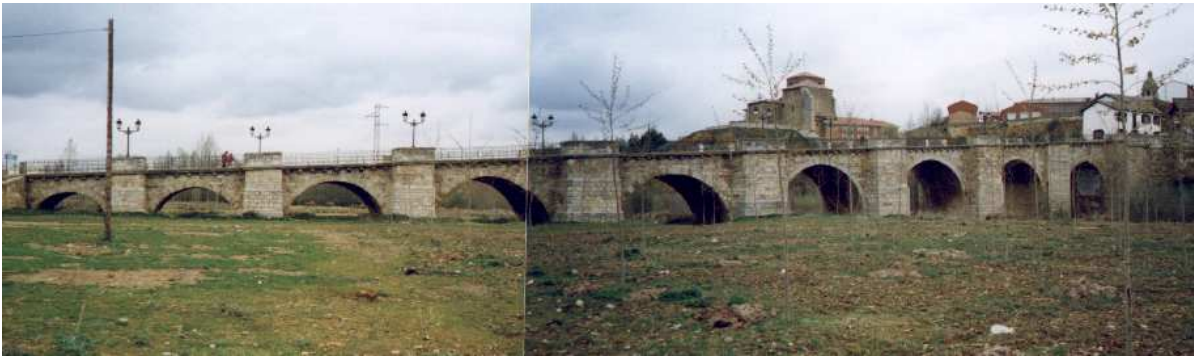
Ilustración 120. Foto de conjunto del puente en Carrión de los Condes (aguas abajo).
