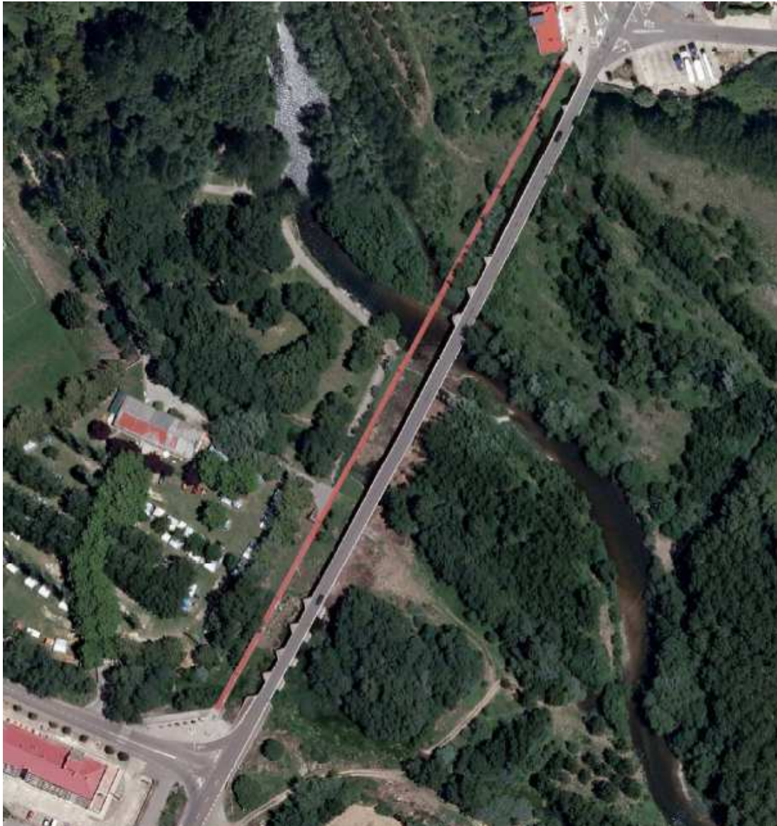
Ilustración 92. Vista aérea del puente en Saldaña.
