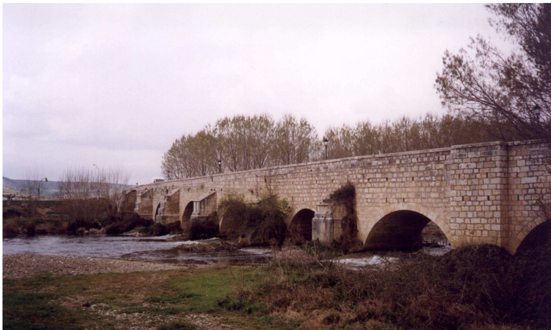
Ilustración 222. Foto de detalle de espolones del puente en Villamuriel de Cerrato desde margen izquierda.
