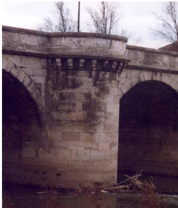
Ilustración 213. Foto de detalle de tajamar del puente Mayor.
