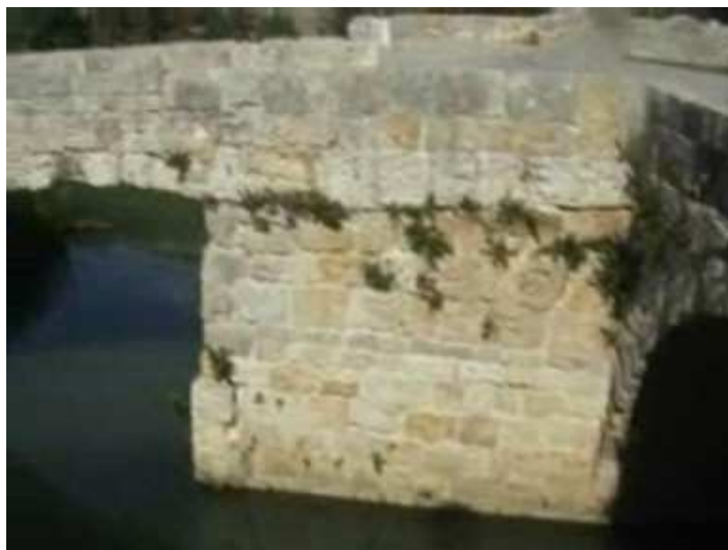
Ilustración 190. Foto de rampa de acceso a ínsula desde pila nº 3 en puente de Puentecillas.
