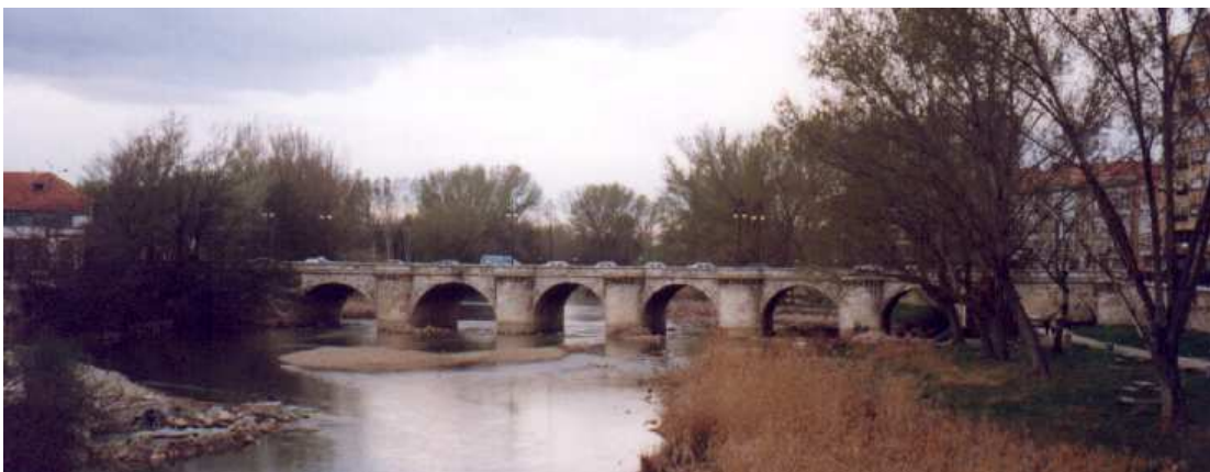
Ilustración 214. Foto de conjunto del puente Mayor (aguas abajo).
