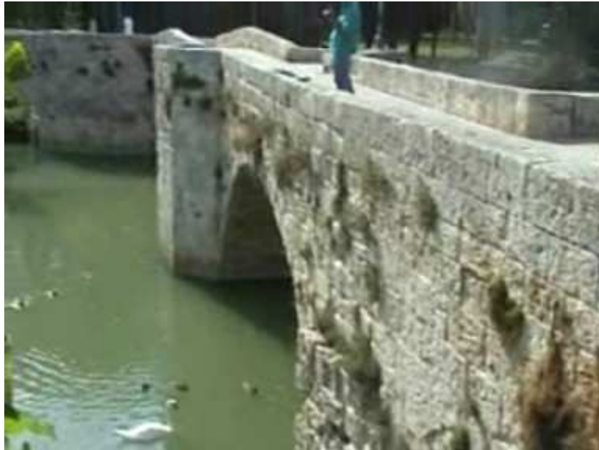
Ilustración 194. Foto de espolón achaflanado en puente de Puentecillas.
