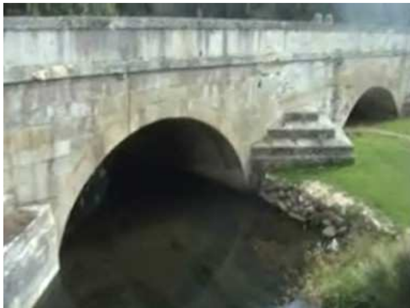
Ilustración 100. Foto de tamares bajos y en ángulo recto en puente en Saldaña.
