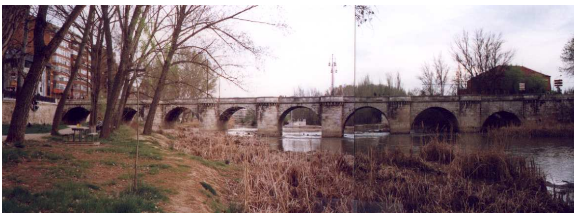
Ilustración 200. Foto de conjunto del puente Mayor (aguas arriba).
