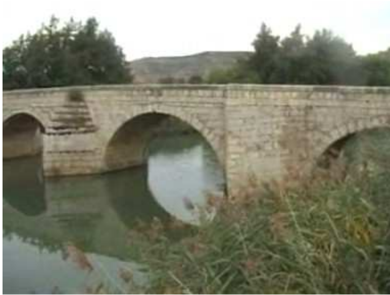
Ilustración 164. Foto de tajamares en puente en Husillos.
