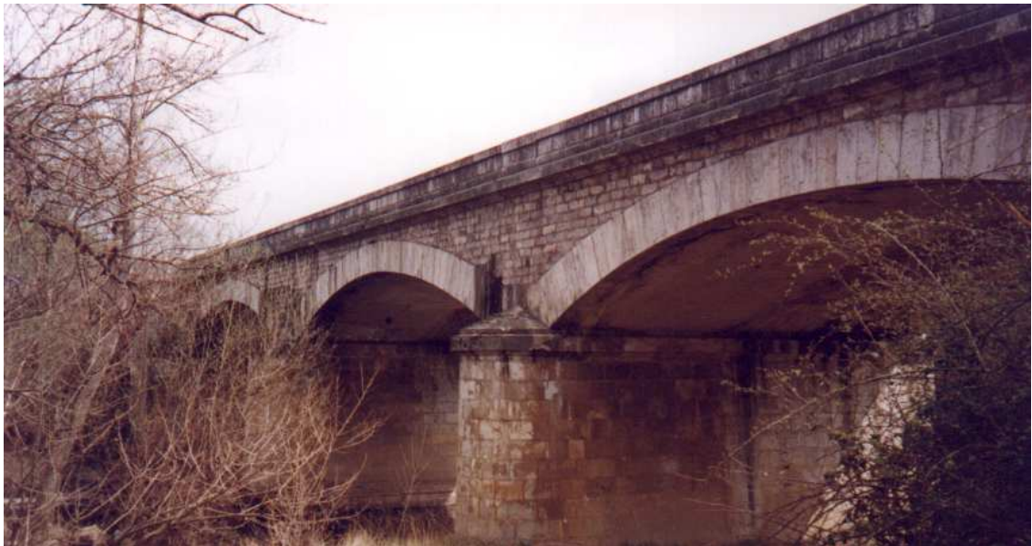
Ilustración 233. Foto de detalle de arcos y pila en puente de San Isidro en Dueñas.
