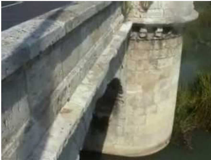
Ilustración 206. Foto de detalle de enrase de pila ampliada y tajamar en puente Mayor.
