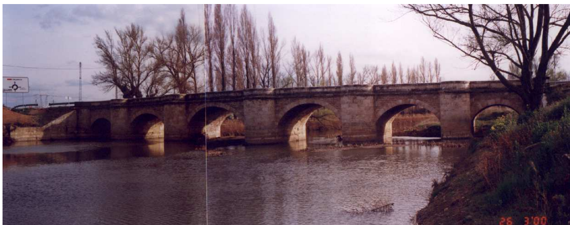
Ilustración 173. Foto de conjunto del puente de Don Guarín (aguas arriba).
