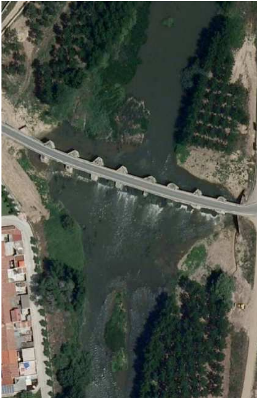
Ilustración 216. Vista aérea del puente en Villamuriel de Cerrato.
