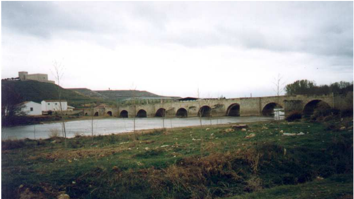
Ilustración 148. Foto de conjunto del puente en Monzón de Campos (aguas arriba).
