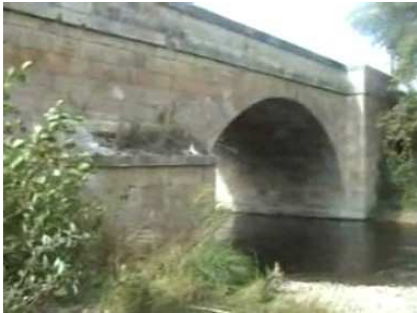
Ilustración 104. Foto de espolones rectangulares en puente en Saldaña.
