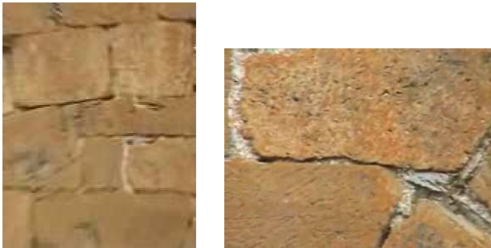
Ilustración 70. Foto de detalle de juntas en puente medieval en Velilla del río Carrión.
