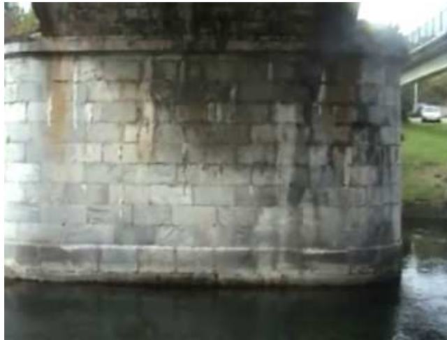
Ilustración 58. Detalle de sillares en pila del puente en Velilla del río Carrión
