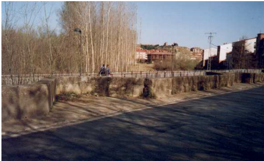
Ilustración 93. Foto de la calzada del puente en Saldaña.
