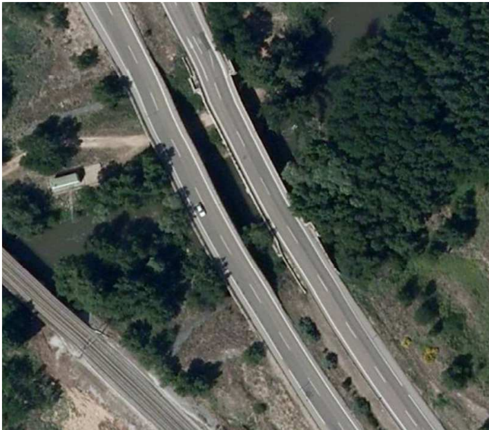
Ilustración 229. Vista aérea del puente de San Isidro en Dueñas.
