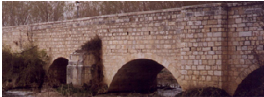
Ilustración 223. Foto de detalle de mechinales en puente en Villamuriel de Cerrato.
