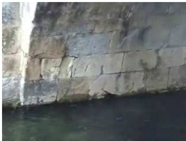
Ilustración 85. Foto de sillares de arco y unión con pila en puente en Guardo.
