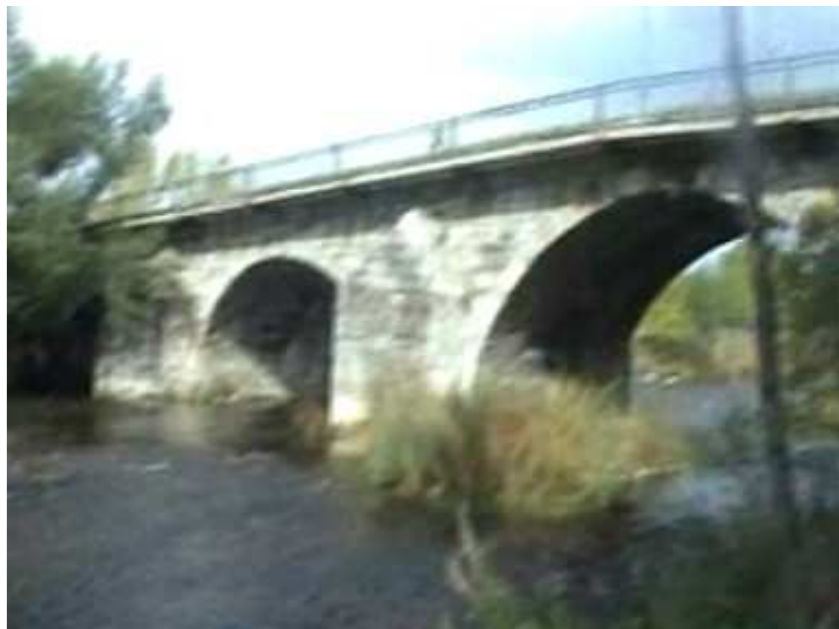
Ilustración 83. Foto de arcos y espolones en Puente en Guardo.
