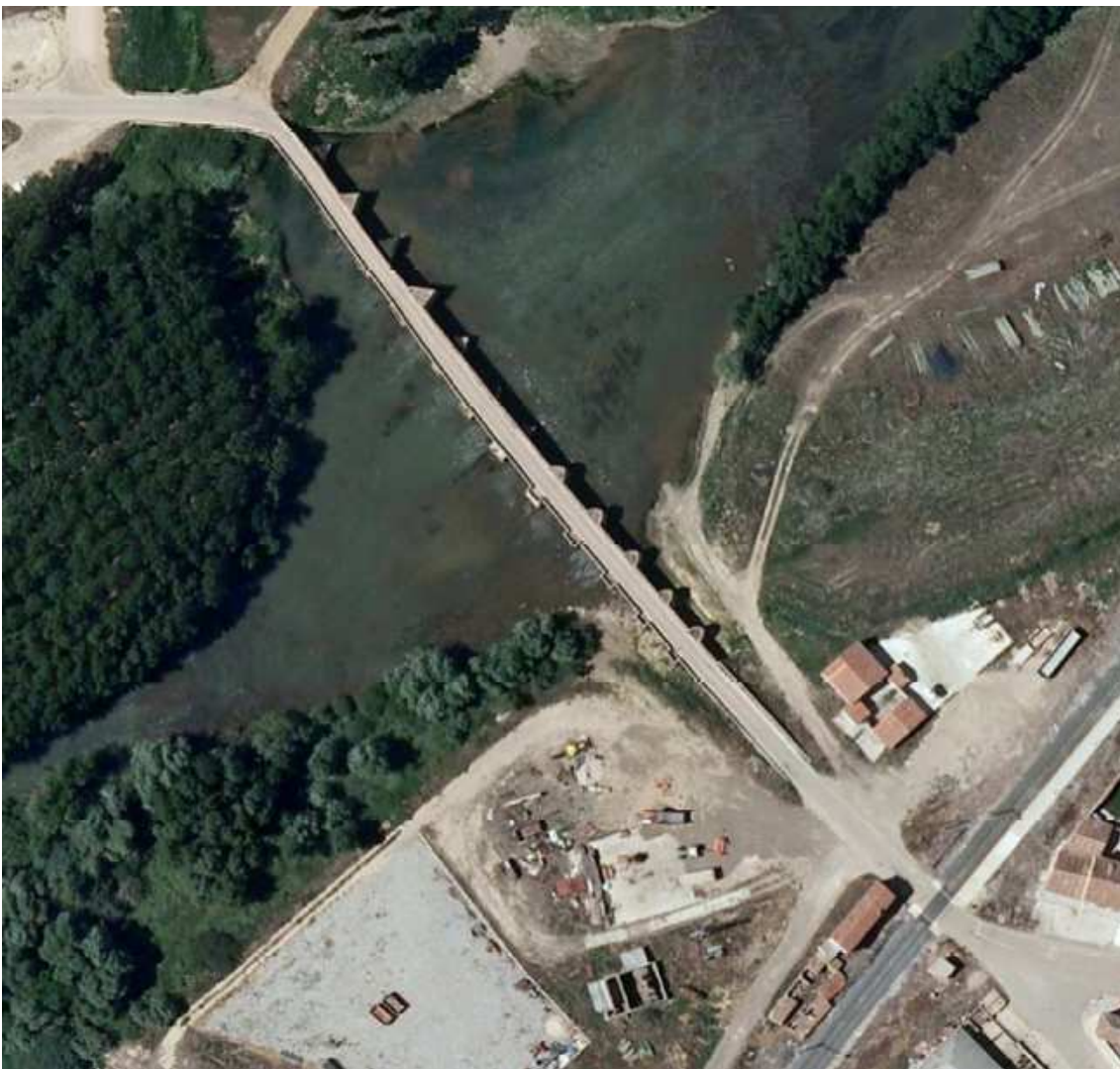
Ilustración 146. Vista aérea del puente en Monzón de Campos.
