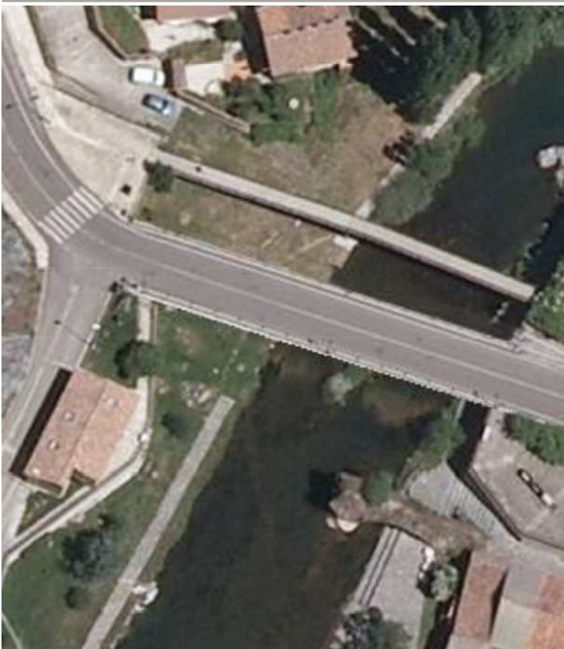
Ilustración 50. Vista aérea del puente en Velilla del río Carrión.
