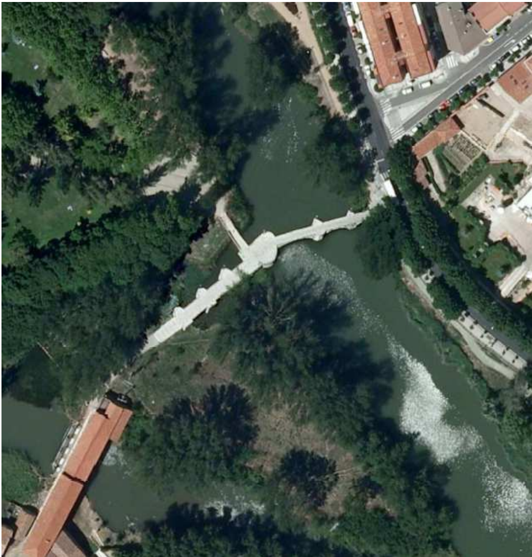
Ilustración 182. Vista aérea del puente de Puenteillas.
