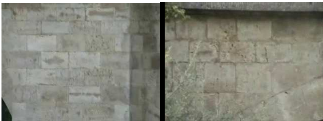
Ilustración 140. Foto de detalle de sillares en pilas y tímpanos en puente en Villoldo.
