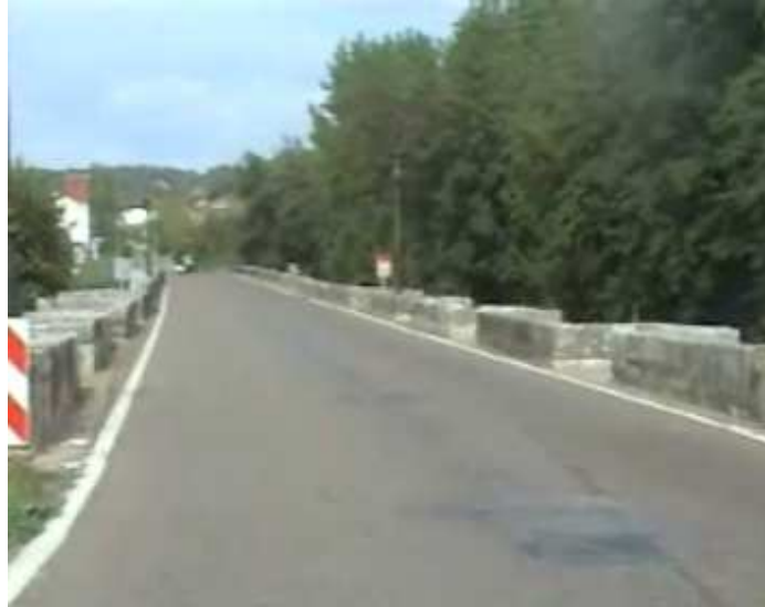
Ilustración 105. Foto de calzada y pretil en puente en Saldaña.
