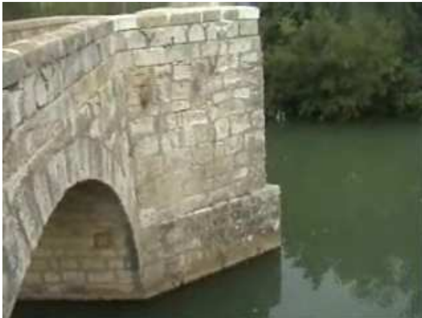
Ilustración 166. Foto de detalle de diferente morfología de sillares en el recrecido de espolón en puente de Husillos.
