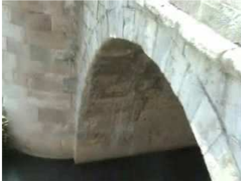
Ilustración 205. Foto de detalle de falta de enrase de pila ampliada y tajamar en puente Mayor.
