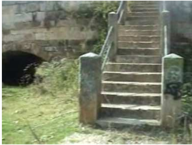
Ilustración 112. Foto de escalera en puente en Saldaña.
