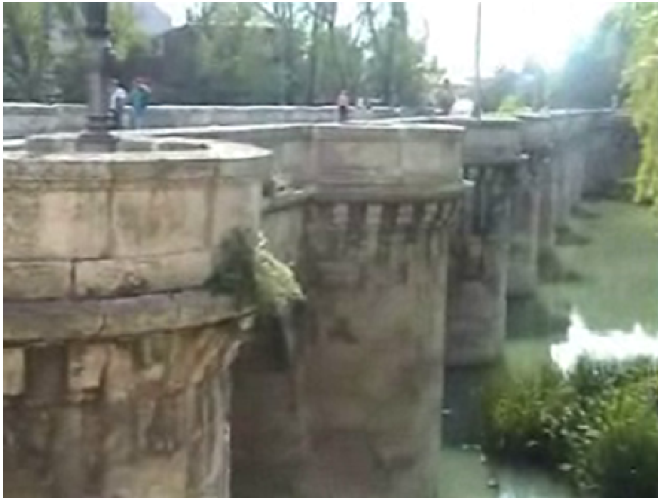
Ilustración 208. Foto de detalle de espolones del puente Mayor.
