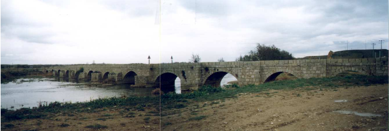
Ilustración 147. Foto de conjunto del puente en Monzón de Campos ( aguas abajo).
