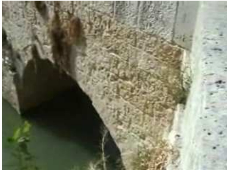
Ilustración 189. Foto de arco nº 6 en puente de Puentecillas.
