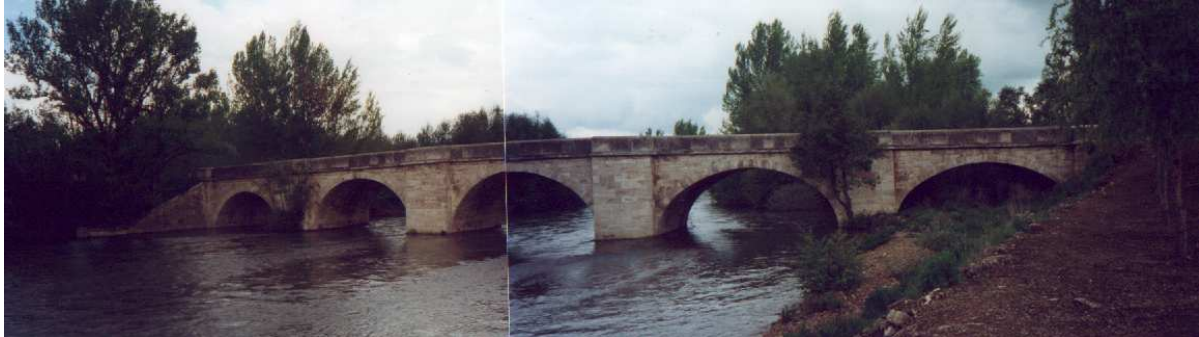
Ilustración 133. Foto de conjunto del puente en Villoldo.
