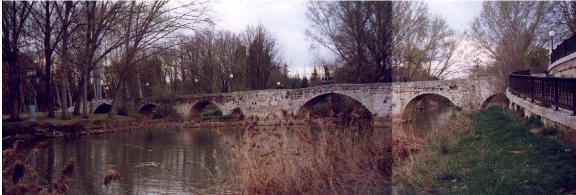
Ilustración 183. Foto de conjunto del puente de Puentecillas.
