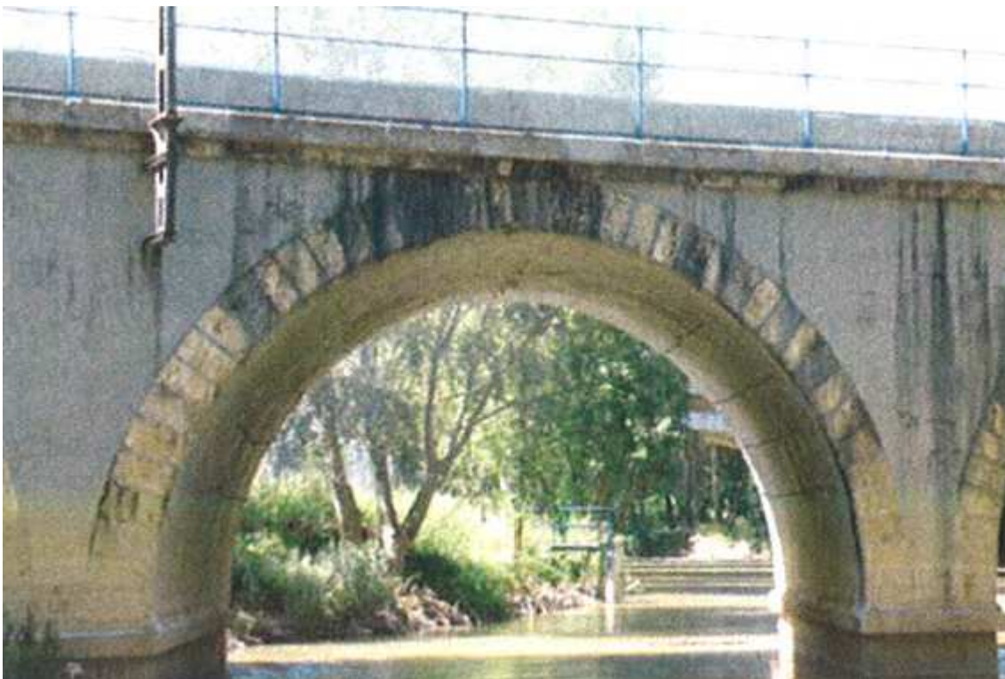
Ilustración 243. Foto de detalle de arcos y pila en puente del ferrocarril en Dueñas.
