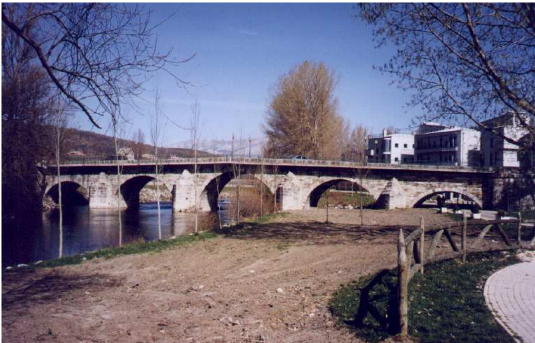
Ilustración 80. Foto de conjunto del puente en Guardo.
