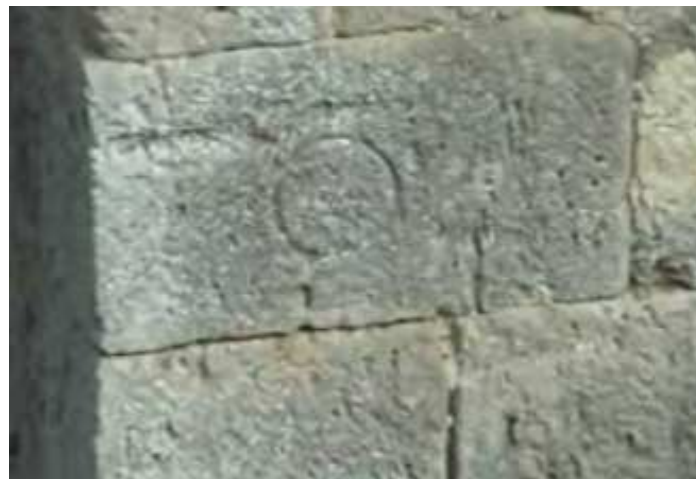
Ilustración 108. Fotos de marcas con círculo en puente en Saldaña.
