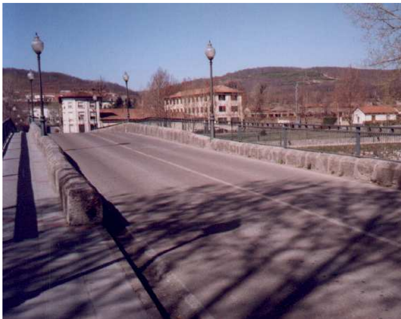
Ilustración 90. Foto de la calzada del puente en Guardo.
