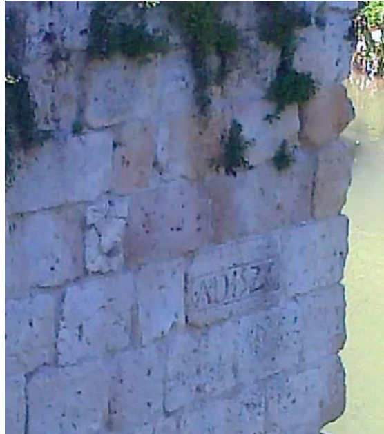
Ilustración 187. Foto de tajamar de la pila nº 4 con inscripción en puente de Puente de Puentecillas.
