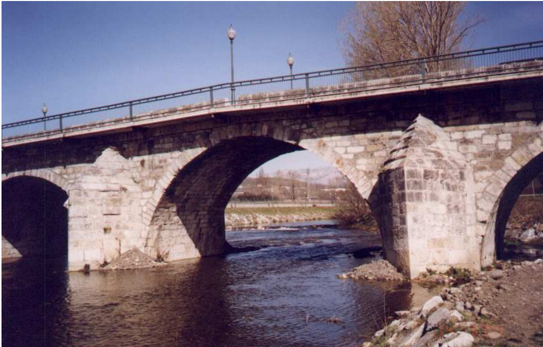
Ilustración 79. Foto de detalle del puente en Guardo.
