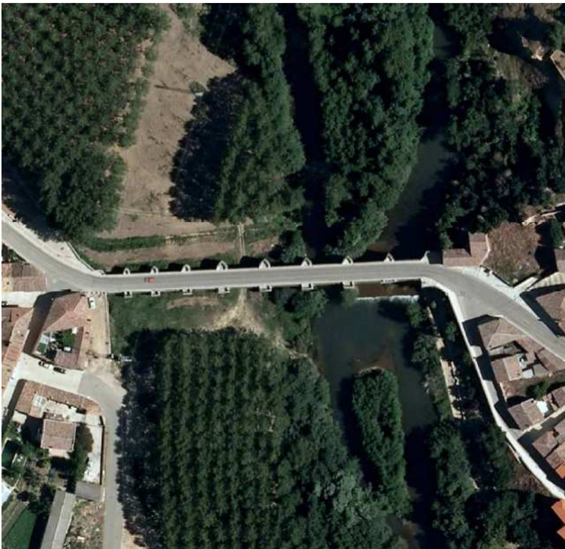
Ilustración 118. Vista aérea del puente en Carrión de los Condes.
