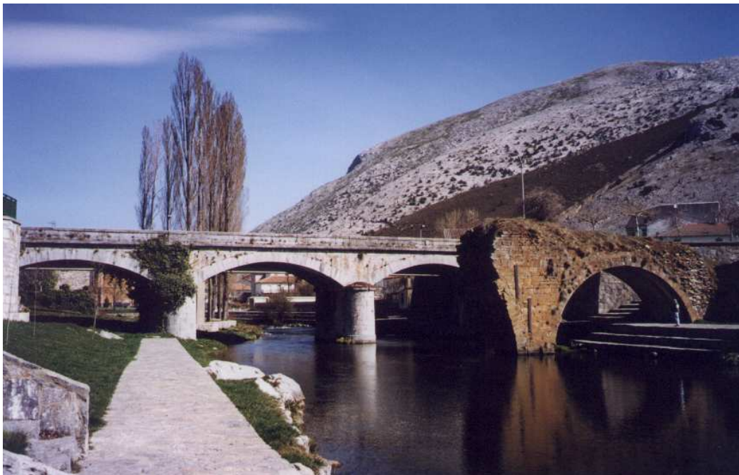
Ilustración 52. Foto de conjunto del puente en Velilla del río Carrión (1999).
