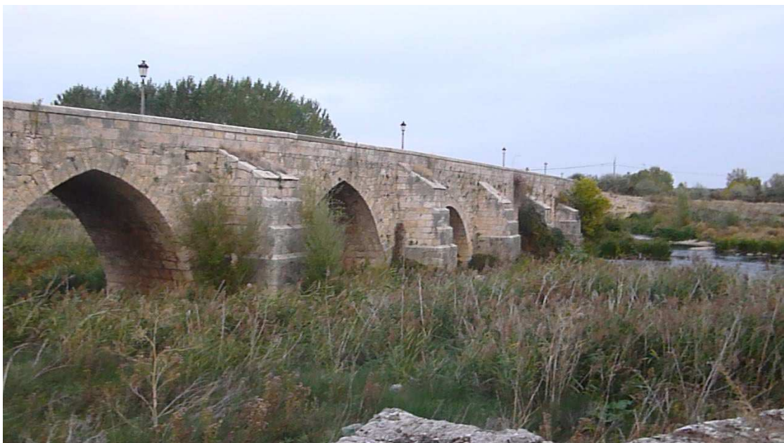
Ilustración 221. Foto de detalle de espolones del puente en Villamuriel de Cerrato desde margen derecha.
