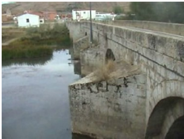
Ilustración 152. Foto de detalle de zona central ensanchada en Puente en Monzón
