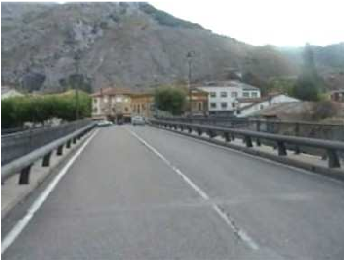
Ilustración 53. Foto del estado actual del puente en Velilla del río Carrión.
