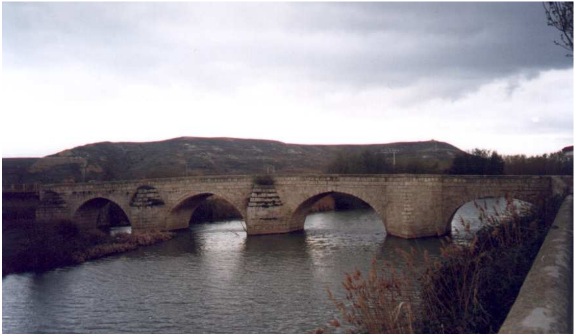
Ilustración 161. Foto de conjunto del puente en Husillos (vista frontal).
