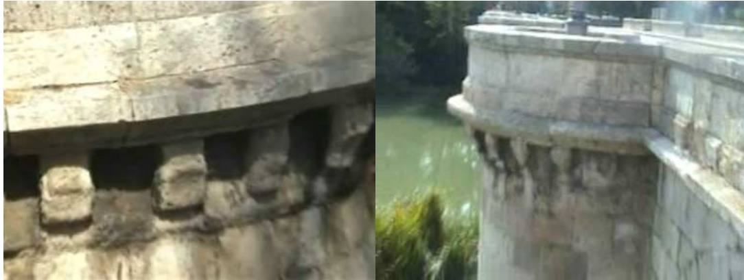
Ilustración 209. Foto de detalle de imposta en puente Mayor.
