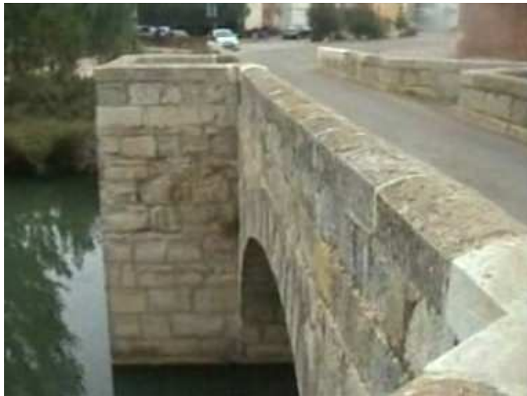
Ilustración 165. Foto de detalle de espolón en Puente en Husillos
