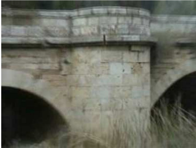
Ilustración 177. Fotos de detalle de tajamares y espolones del puente de Don Guarín.
