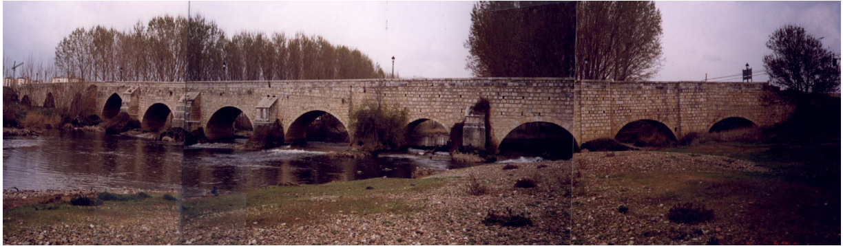
Ilustración 217. Foto de conjunto del puente en Villamuriel de Cerrato (aguas abajo).
