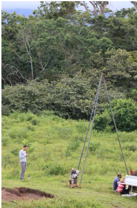
Figura 6-18: Fase de montaje de tinglado de tres varillas con polea y motor con cabrestante para elevación de martillo de seguridad en Costa Rica
