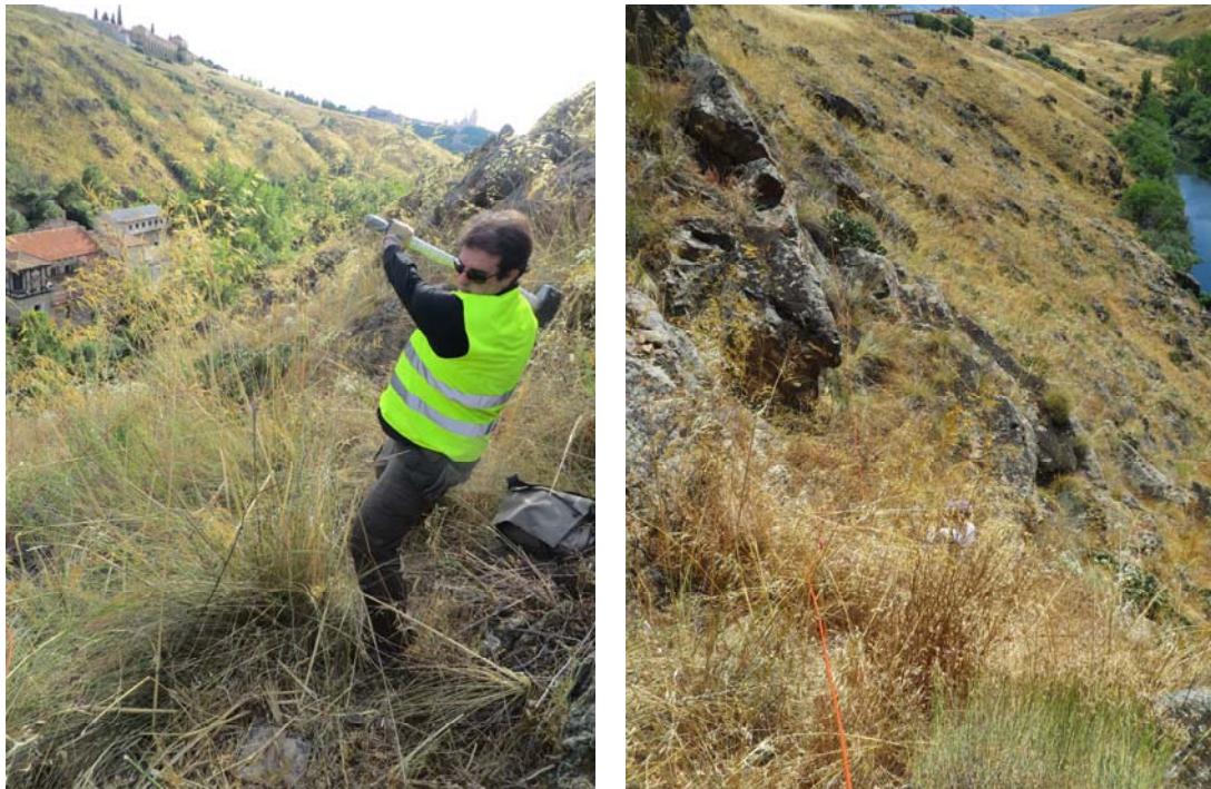
Figura 4-30: Sísmica de refracción para estimación de ripabilidad de una ladera en materiales ortogneisíticos glandulares para la ejecución de una conducción mediante tunelación en Segovia
