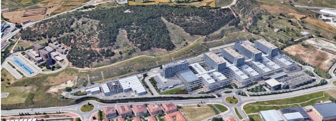
Figura 1: Hospital Universitario de Burgos – HUBU
