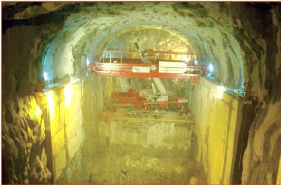
Merecen destacarse dos incidentes fundamentales surgidos durante la excavación. El primero se refiere a la aparición, durante la excavación de la bóveda, de un elemento anómalo dentro del cuerpo ígneo granítico, como fue un dique intrusivo de composición básica.
