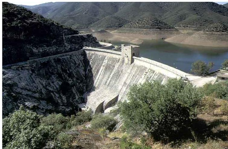
El tipo de presa es de gravedad, de planta curva y sección triangular, cuenta con una altura de 83.5 metros sobre el cauce, tiene una longitud de 240 metros. A pie de presa se encuentra integrada la central hidroeléctrica.
