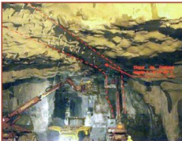
El segundo incidente fue la aparición, tanto en bóveda como en hastiales, de cuñas de terreno que se desprendían, fundamentalmente en la fase del obligado saneo, produciendo inevitables sobreexcavaciones que exigieron la reconstrucción a su geometría definitiva, con hormigón encofrado, de parte de los hastiales de la caverna, ya que en muchas zonas llegaba incluso a no haber apoyo para las vigas carril.
