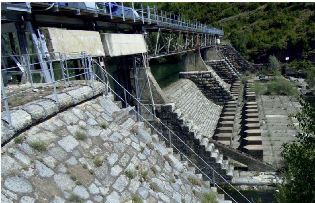
La cimentación se hizo con pozos indios (cajones de aire comprimido) hasta la roca. Es de destacar la calidad de los remates de piedra del azud, de la toma de las embocaduras de los túneles etc. Resulta llamativo su buen estado de conservación después de 100 años de funcionamiento.
