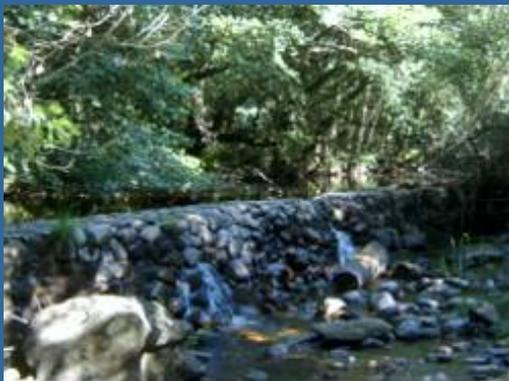
Zúa, (azuda, azud o presa) que embalsa el agua para el funcionamiento de la aceña. Tiene algo más de un metro de altura y unos cien metros de longitud.
