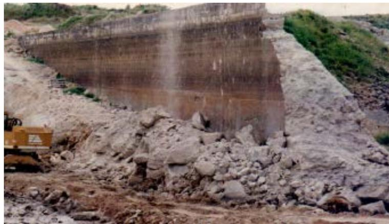
En las fotos de la obra de la nueva presa y en la fase de demolición, puede apreciarse la tipología de la presa original y los materiales que se utilizaron en la construcción de la misma.
