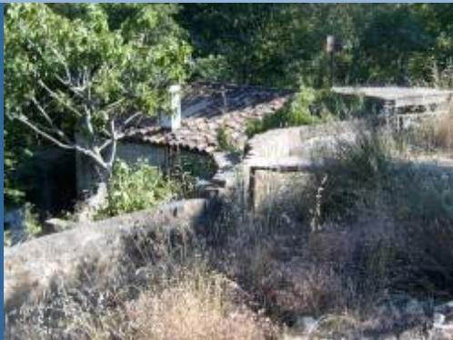
Molino, situado al lado del anteriormente descrito. Ya no funciona, porque no tiene instaladas ni las muelas ni el rodezno. Es un molino con cubo, a donde llega el agua a través de un canal. Durante algún tiempo funcionó como central hidroeléctrica.
