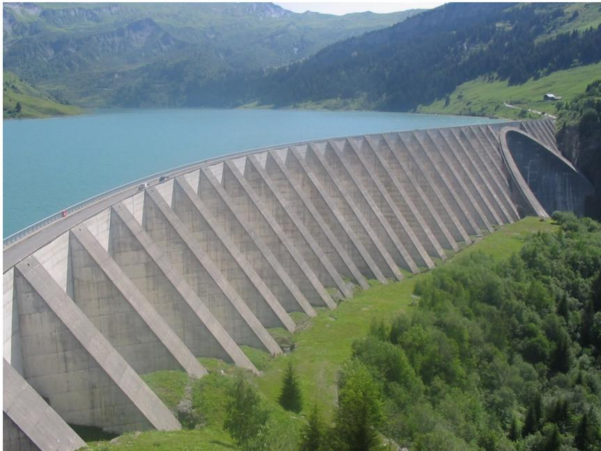
Rápidamente la construcción de presas se convierte en una técnica muy flexible por la multiplicación de formas gracias al empleo del hormigón armado. Las bóvedas múltiples y los contrafuertes aparecían como la solución que podía adaptarse a cualquier sitio en el que se quisiera implantar una presa.
