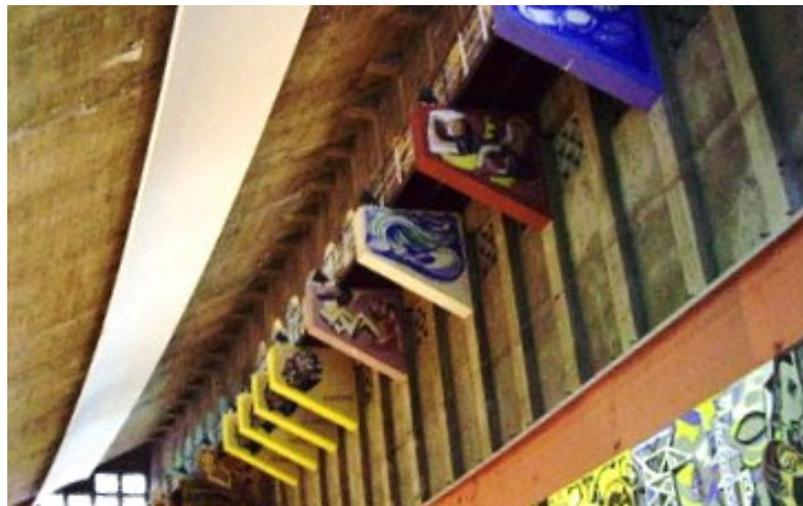
*Cubierta y ménsulas de la sala de turbinas*
