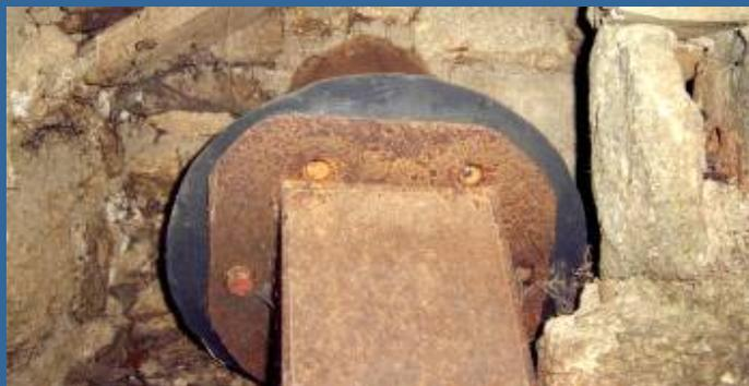
Saetín y cerraña del molino. El saetín es la tobera que conduce el agua a presión desde el fondo del cubo al rodezno haciéndole girar. La cerraña es una pequeña compuerta al final del saetín que permite regular el caudal de agua. Esta compuerta se accionaba con un mecanismo, llamado "llave del saetín" situado junto a las muelas.
