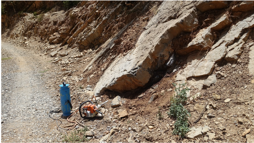
Figura. 4.1. Perforadora de gasolina portátil y sistema de refrigeración de la Universidad de Burgos.
