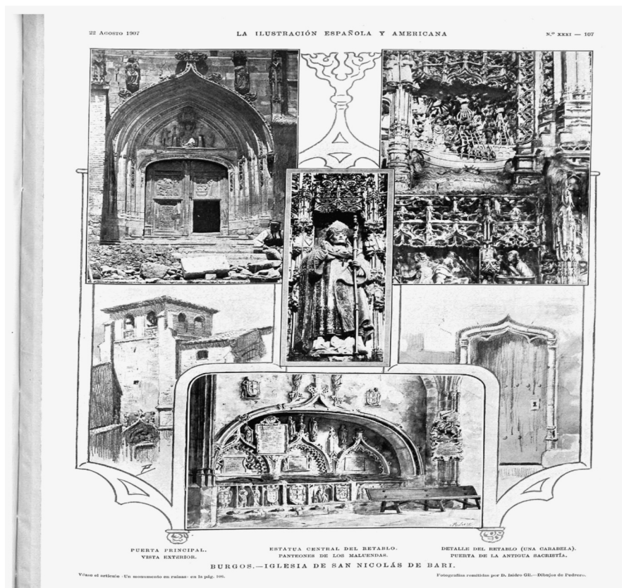
Imágenes de la Iglesia de San Nicolás de Bari Izquierda: Puerta principal y vista exterior; Centro: Estatua central del retablo y panteones de los Maluendas; Derecha: Detalle del retablo (una carabela) y puerta de la sacristía La Ilustración española y americana , Madrid (22-VIII-1907)
