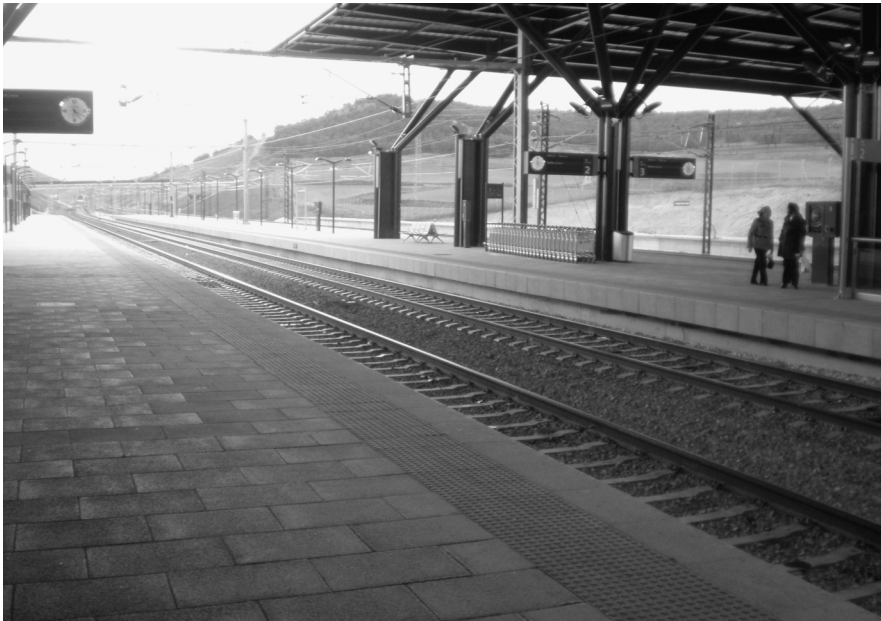
Exterior de la actual estación “Rosa de Lima Manzano”
