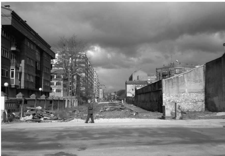
Primeros trabajos de desmontaje de las vías en Santa Dorotea
