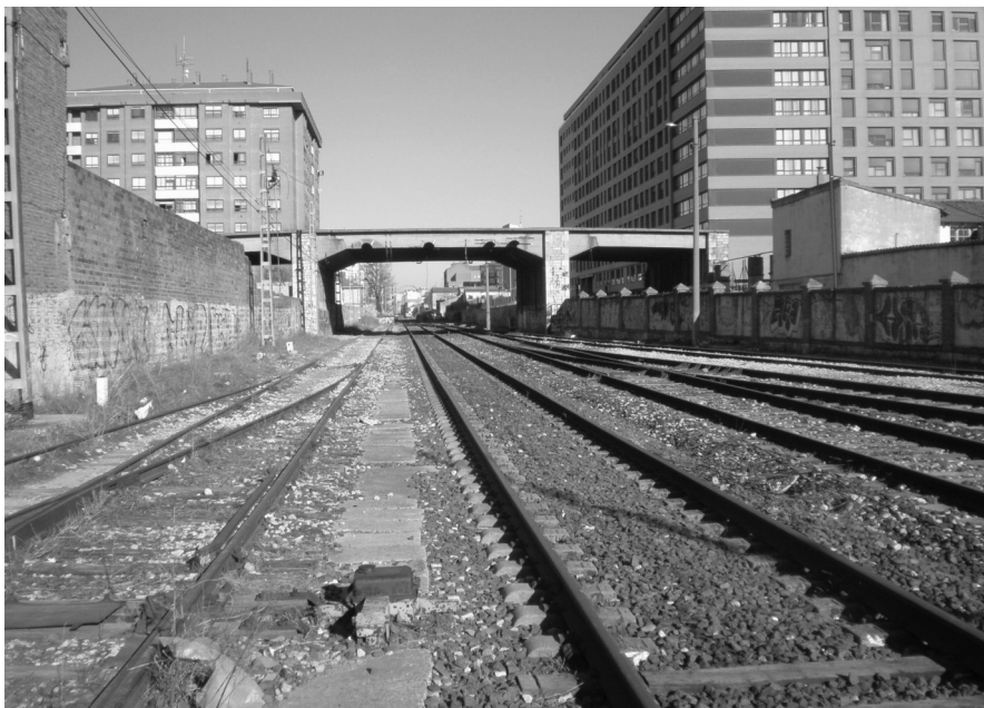
Al fondo el paso superior de la fallida Avenida de Madrid
