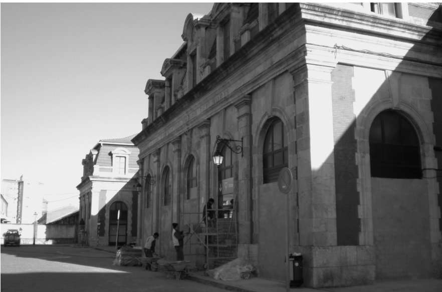
Fachada principal de la anterior estación que se conservará
