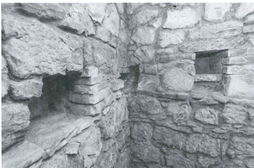
Fig. 12. Interior del pozo de nieve de Siete Infantes de Lara, 24 en la que puede apreciarse la mampostería de los muros. Fotografía de Alberto Rodrigo
