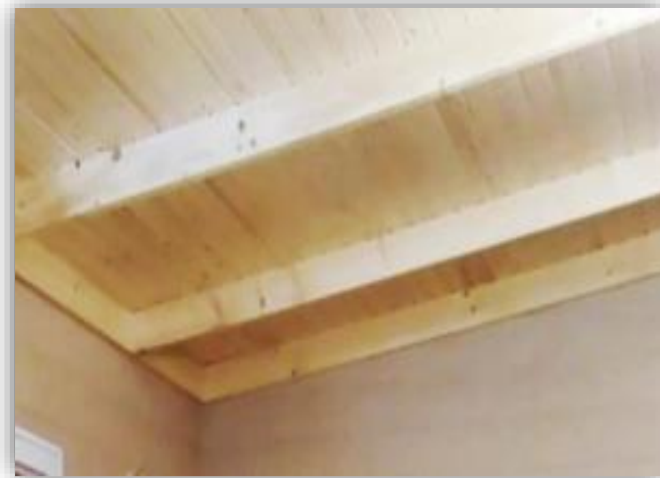
Ilustración 7: Acabado interior y exterior de cubierta: pino nacional y tejado ligero ventilado.
