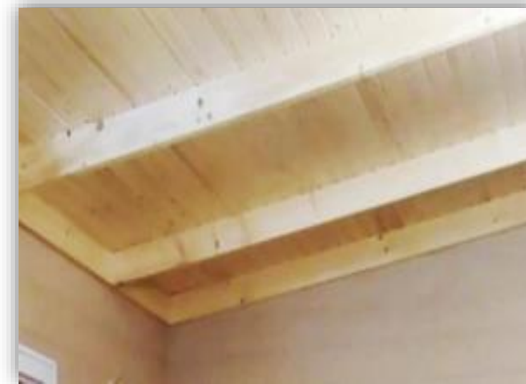
Ilustración 4: Acabado interior y exterior de cubierta: pino nacional y tejado ligero ventilado.
