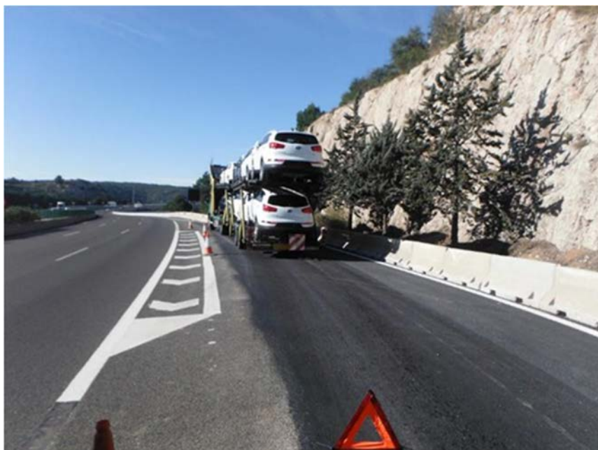
Figura 1: Apartadero de emergencia.
