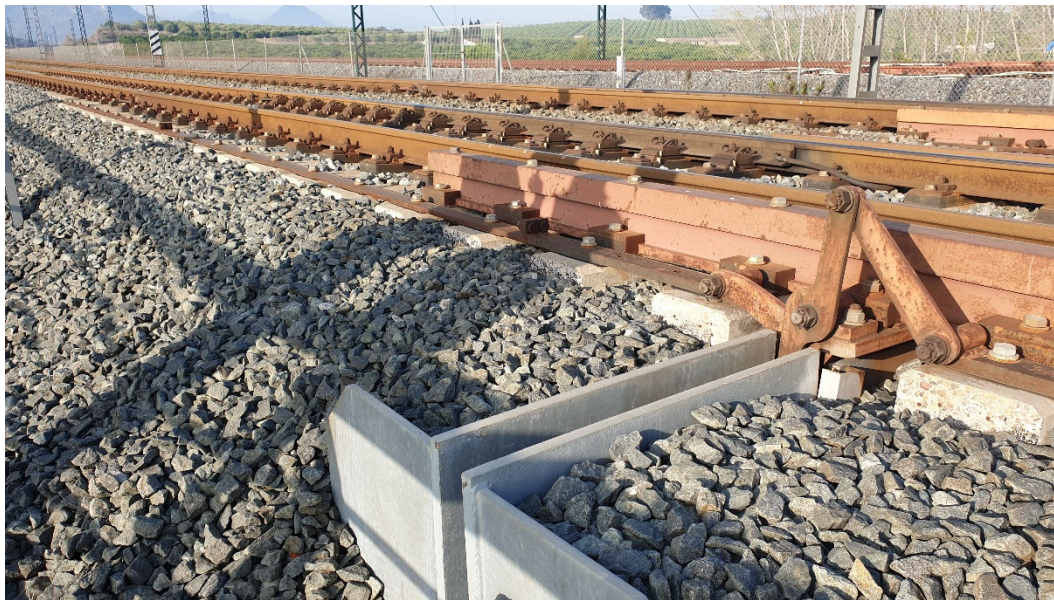
Fig. 1 – Aparato y junta de dilatación. Fuente: elaboración propia.
