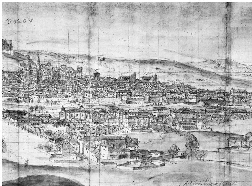
Burgos, 1565. Detalle del grabado de Wyngaerde en el que se aprecian las construcciones del Hospital de la Concepción y su entorno urbano
