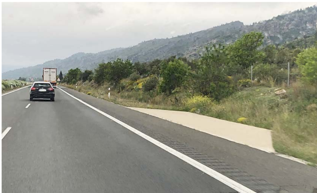
Figura 6: Apartadero exterior reducido.
