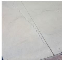
Figura 9: Realización de juntas de retracción tardías
