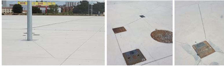
Figura 3: Juntas en elementos rígidos. Alternativa 1
