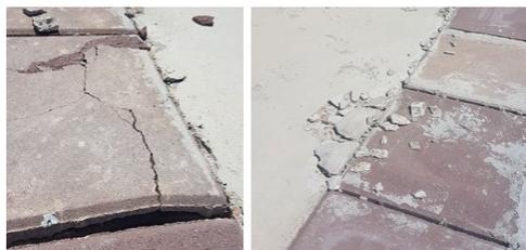
Figura 1: Estallido por compresiones en losa y encintado, por dilatación térmica
