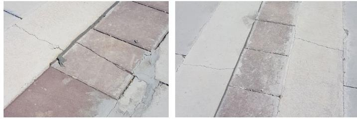
Figura 8: Juntas realizadas automáticamente al no haberlas previsto en la reparación
