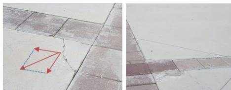
Figura 10: Tensiones principales de tracción y juntas para evitarlas
