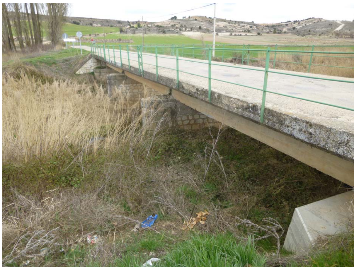
Figura 01: Puente antiguo de Casanova al sur de la provincia de Burgos.
