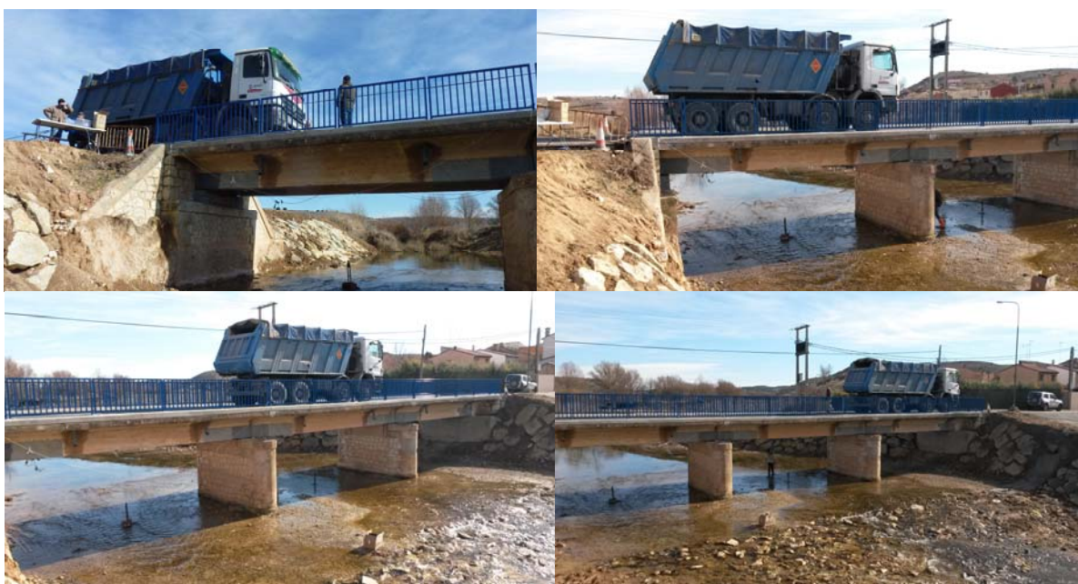
Figura 12: Estados de carga 1 (a), 4 (b), 5 (c) y 6 (d) del Puente de Casanova.
