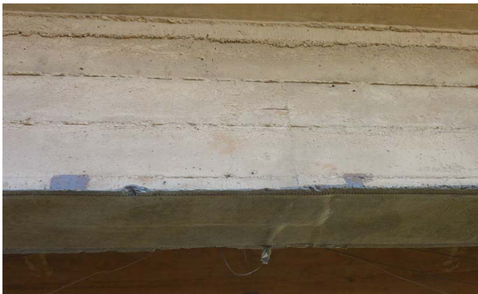
Figura 06: Detalle refuerzo a flexión Puente de Casanova.
