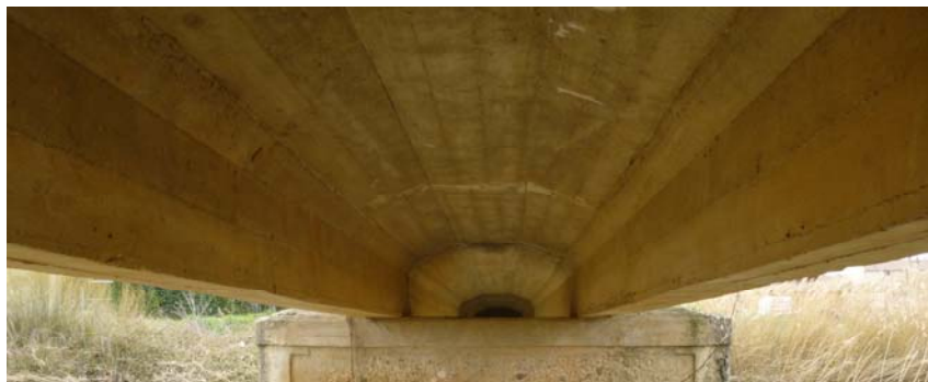
Figura 04: Detalle acartelamiento sección transversal Puente de Casanova.
