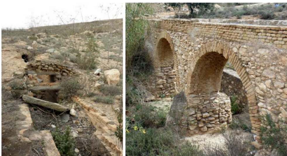
Figura 5. Decantador previo al puente de dos arcos y puente de dos arcos de la Casa de Girón.
