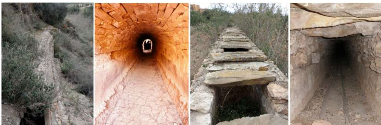
Figura 4. Acequia de bóveda de cañón y acequia rectangular cubierta de la canalización de Casa Grande.
