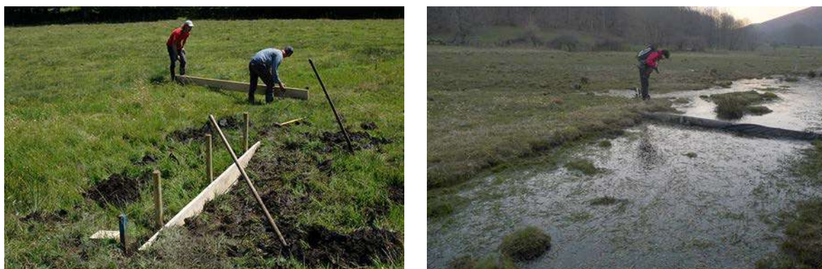
Figura 2. Construcción de un dique en 2008 (izda.); retención de agua por un dique en 2013 (dcha.).
