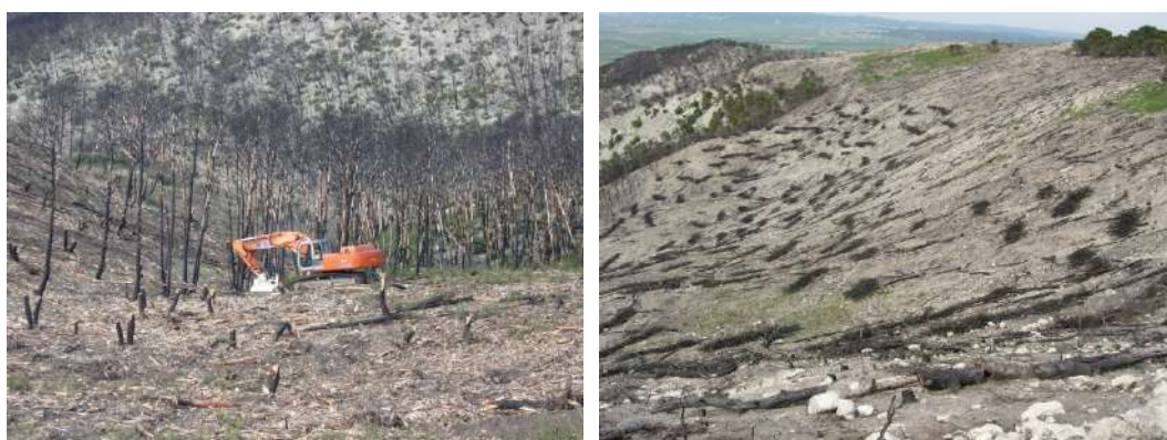
Figura 4. Astillado y deposición, y fajinas en contra pendiente.
