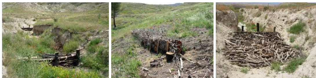
Figura 3. Fajinas y barreras para el control de la erosión en Remolinos-Tauste.
