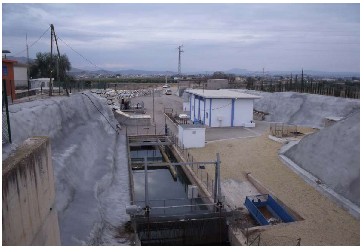
Figura 4. El Saltador (Huércal-Overa), donde convergen las aguas del Canal de la margen derecha del Postravase y las de la Conexión Negratín-Almanzora, y parte la conducción de trasvases a Presa de Cuevas (Fuente: Los autores).
