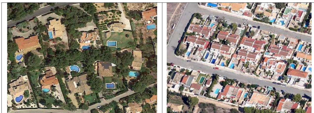
Figura 3. Chalés en el litoral norte (imagen izquierda) y en el litoral sur (imagen derecha). Fuente: http://www.google.maps.es
