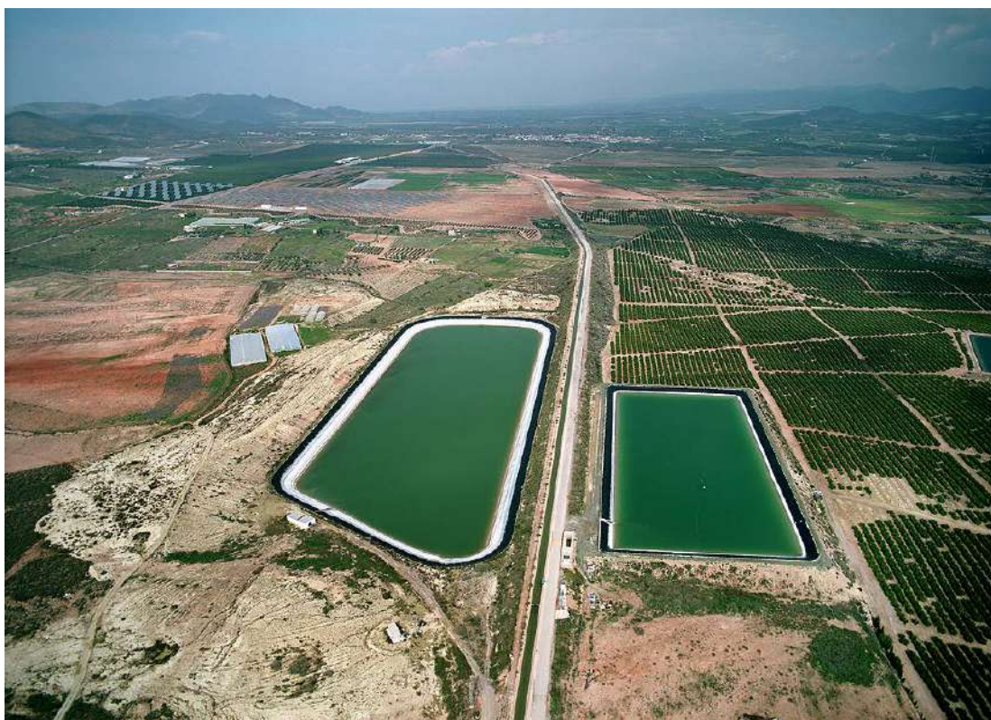
Figura 2. Canal de la Margen Derecha del Postrasvase Tajo-Segura (Fuente: C. R. de Pulpí).
