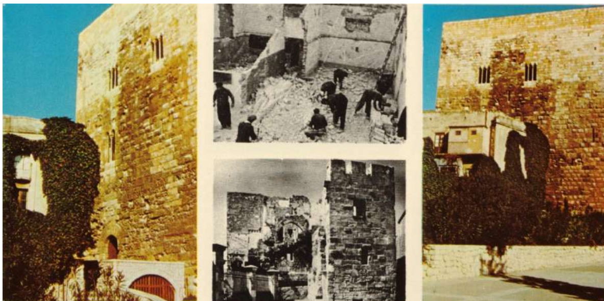
Figura 3. Obras en el Palacio de Augusto. Fuente: Patrimonio Monumental de España. Exposición sobre su conservación y revitalización, 1975.
