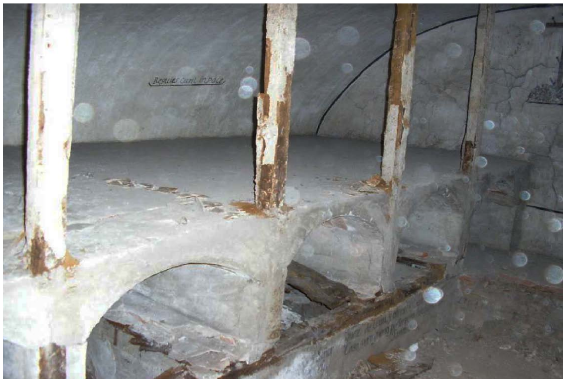
Iglesia de San Martín. Interior de la cripta de los Galdo. Fotografía facilitada por Strato, S.L.
