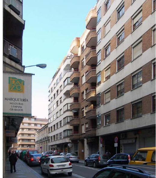
Calle Conde de Ribadeo. La ciudad destruida.
