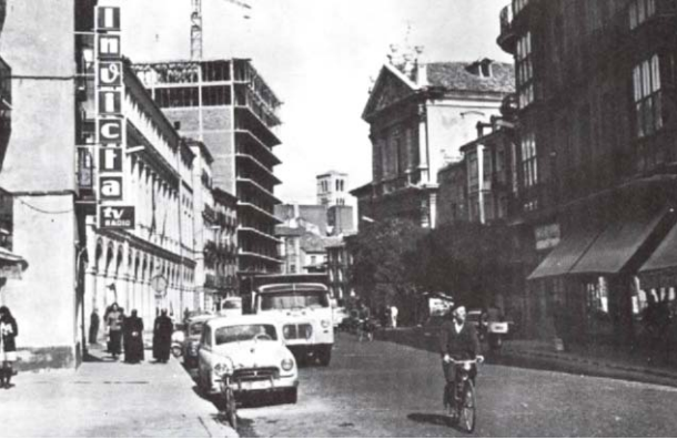
Valladolid años 60, el edificio de calle Angustias en construcción. Tuesta y Vaquero, arquitectos.
