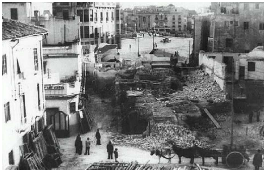
Murcia. Demoliciones para la apertura de la "Gran Vía". Plan Cort.
