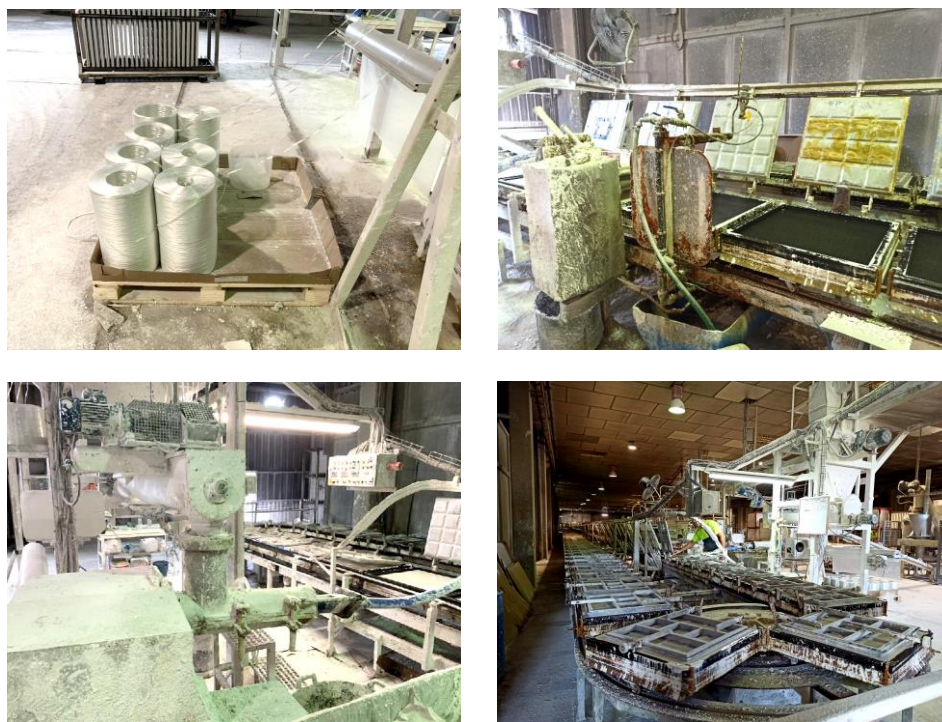
Figura 8.12. Inicio de la línea de producción con la mezcladora existente para producto seco y húmedo y los moldes utilizados
