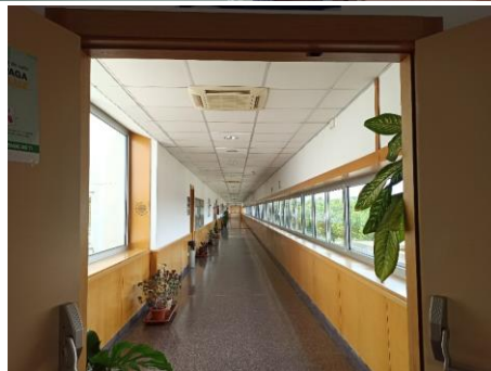
Figura 9.5. Instalación de placas de yeso-PU en el edificio de la Escuela Politécnica Superior (Milanera) de la Universidad de Burgos en Burgos (España)
