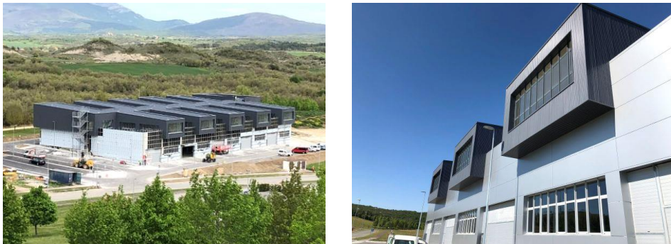
Figura 9.7. Edificio del centro de empresas del Parque Tecnológico de Álava en Miñano (España)
