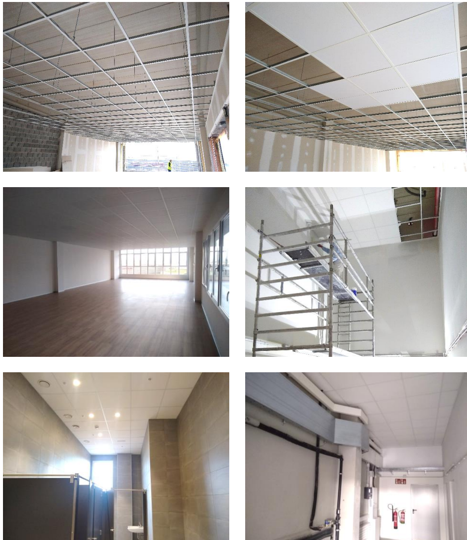
Figura 9.10. Instalación de estructura portante y placas de yeso-PU en el edificio del Parque Tecnológico de Álava en Miñano (España)
