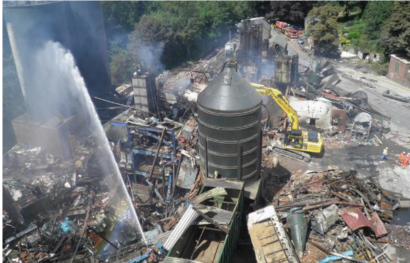
Figura 9. Fotografía de la destrucción provocada por la explosión en la fábrica de suelos laminados de Bosley (UK). (Amyotte, 2014)
