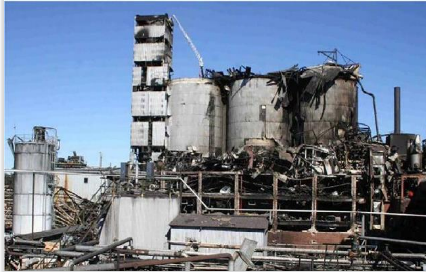
Figura 7. Fotografía de las instalaciones de Port Wentworth (Georgia, EEUU) tras la explosión. (Cloney y Snoeys, 2019)
