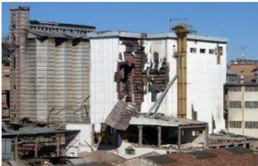
Figura 10. Fotografía de la fábrica de Harinas Porta tras la explosión. (Synthesis Fire Expert, 2005).
