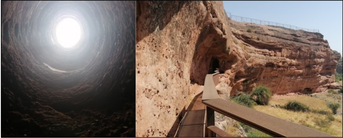
Figura 36. Spiramen y entrada al tramo subterráneo del acueducto.
