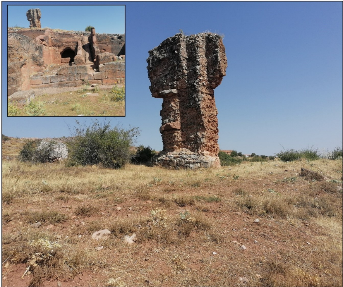
Figura 30. Estructura perteneciente a uno de los muros, posiblemente de la estancia del caldarium , que aún se conserva del complejo de las Termas del Sur.
