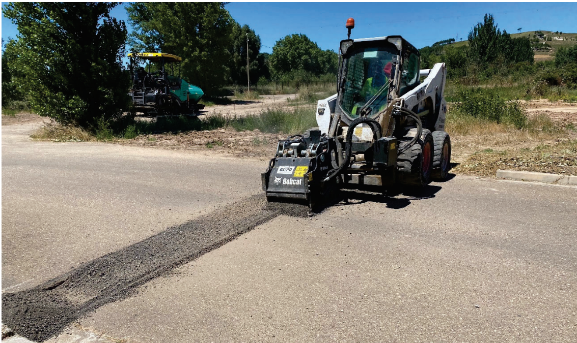
Fresado de juntas transversales
