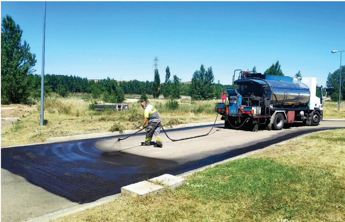
Riego bituminoso de adherencia de la base
