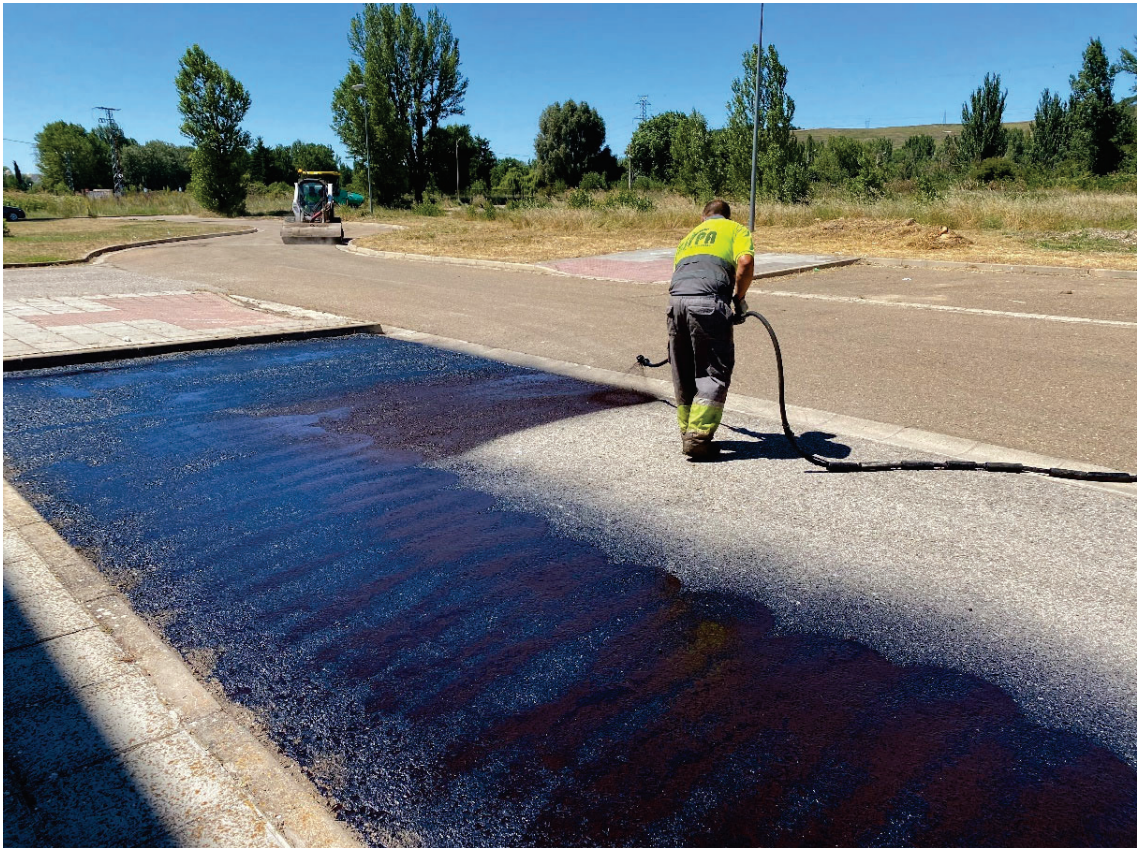
Riego bituminoso de adherencia de la base
