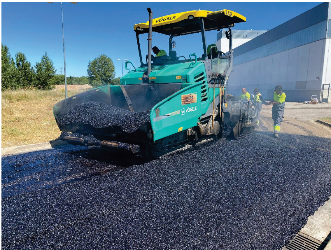
Extendido de la mezcla bituminosa en el tramo de calzada
