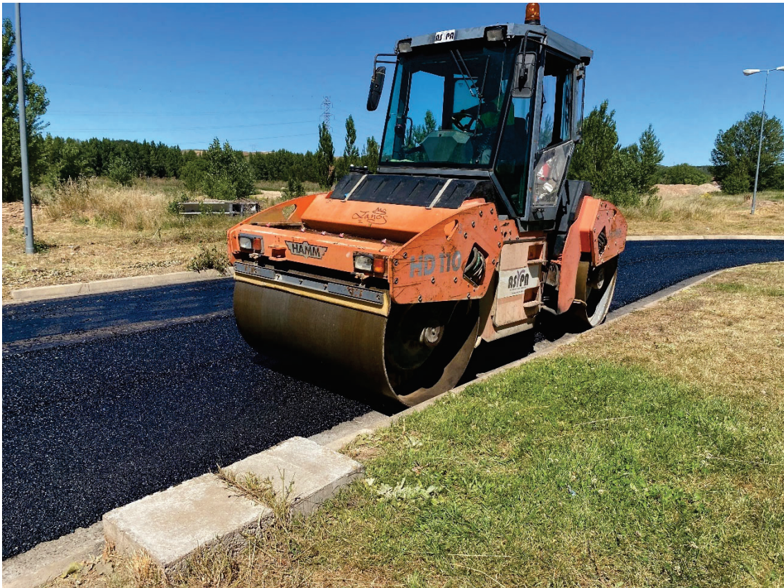
Compactado de la mezcla bituminosa
