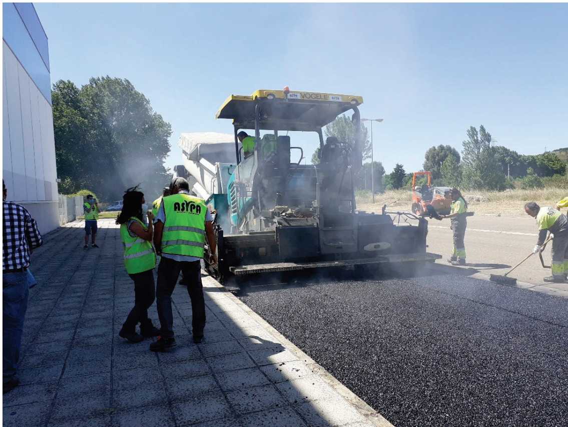
Extendido de la mezcla bituminosa en la superficie del aparcamiento
