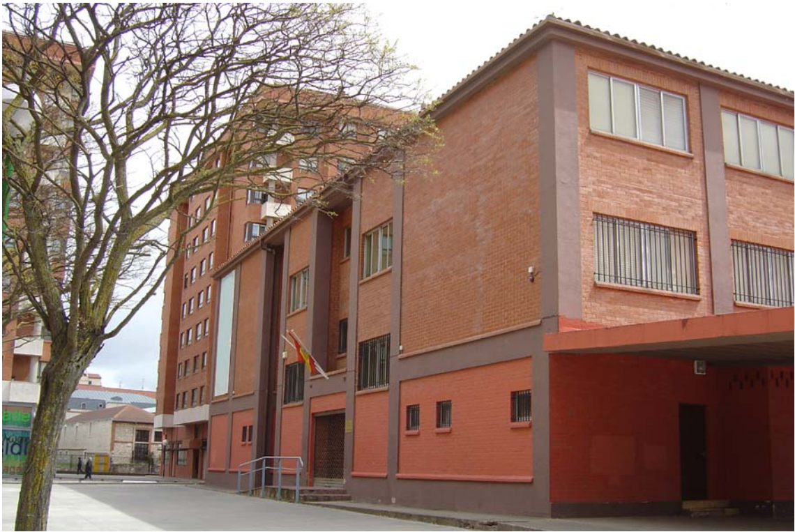
Fachadas Norte y Oeste.
