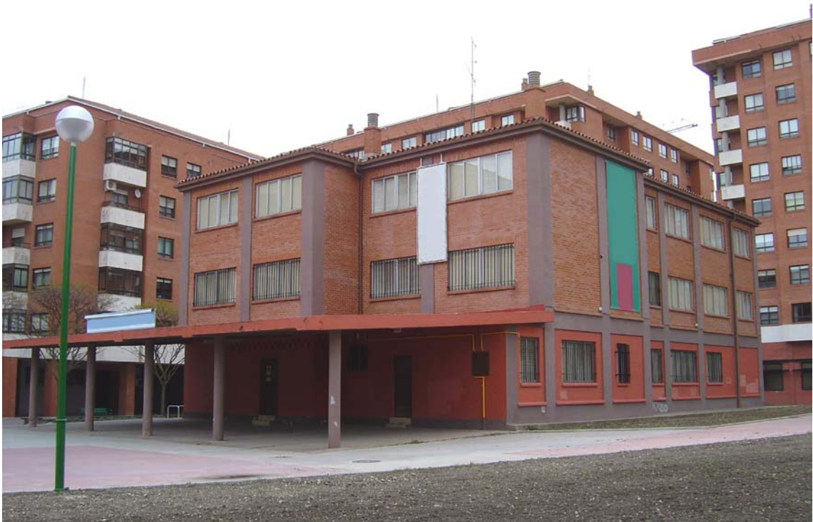
Fachadas Oeste y Sur.
