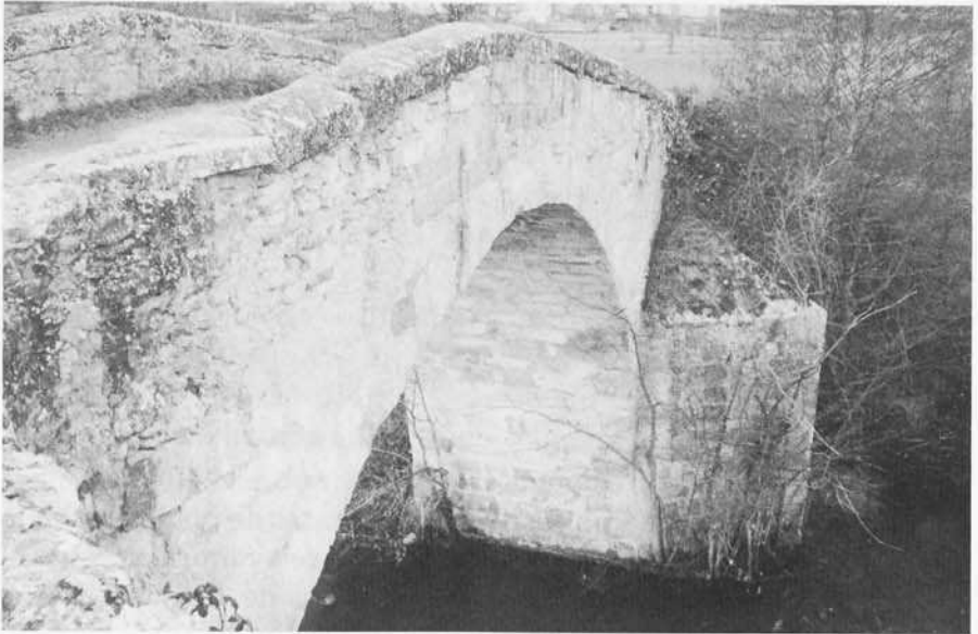
Mijangos: Un arco del puente.
