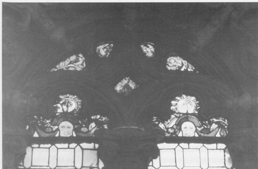
Un rasgo común para la beneficiosa conservación de restos originales ha sido la localización en las tracerías del ventanal. Ventanal noreste (serie baja)
