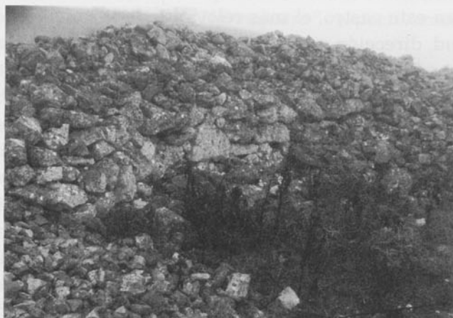
Fig. 2. Paramento externo de la muralla interior.
