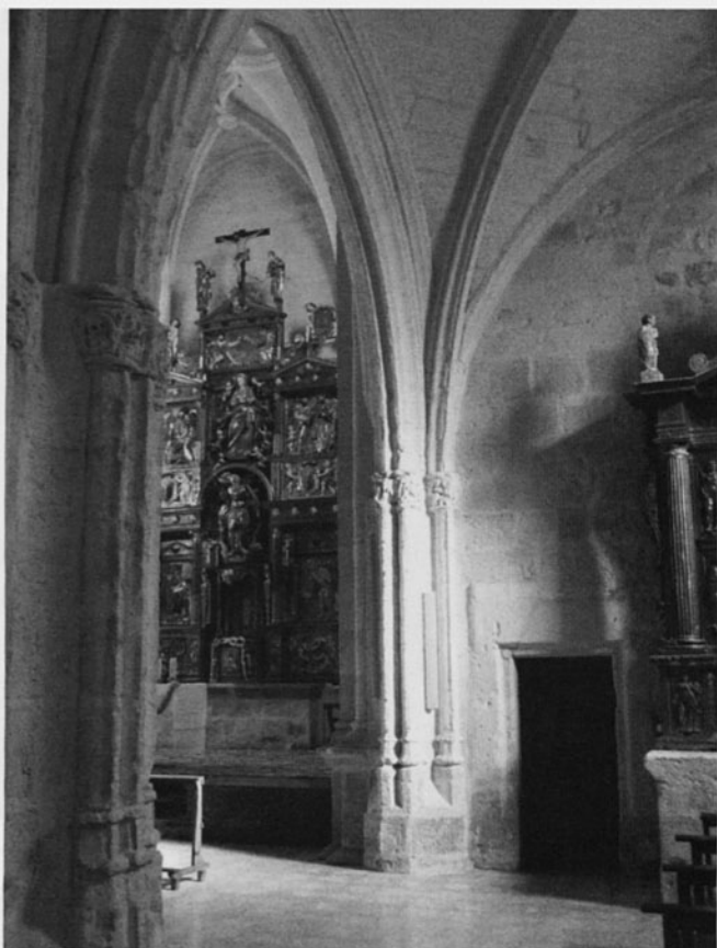
Lámina 3: vista parcial de la nave de la epístola
