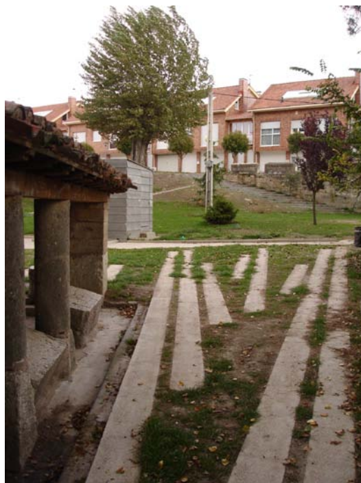
Foto 6. Vista del entorno del lavadero y del acceso desde la carretera después de la intervención.
