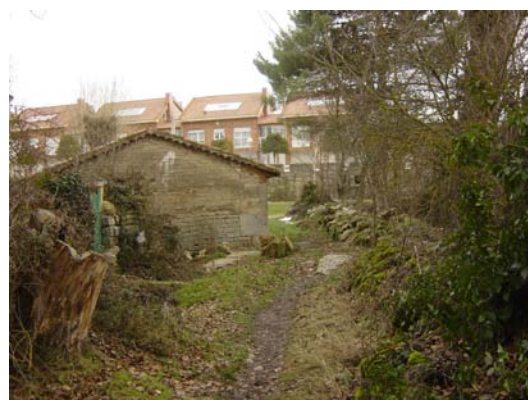
Foto 3. Vista trasera del lavadero antes de la intervención.
