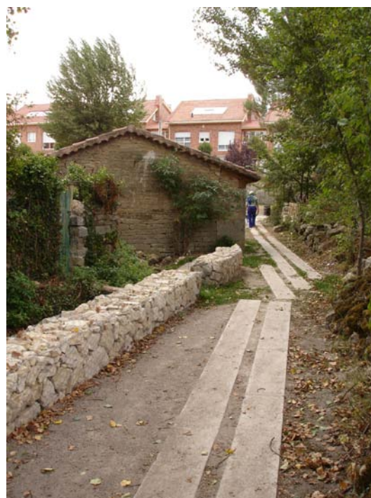
Foto 4. Vista trasera del lavadero después de la intervención.
