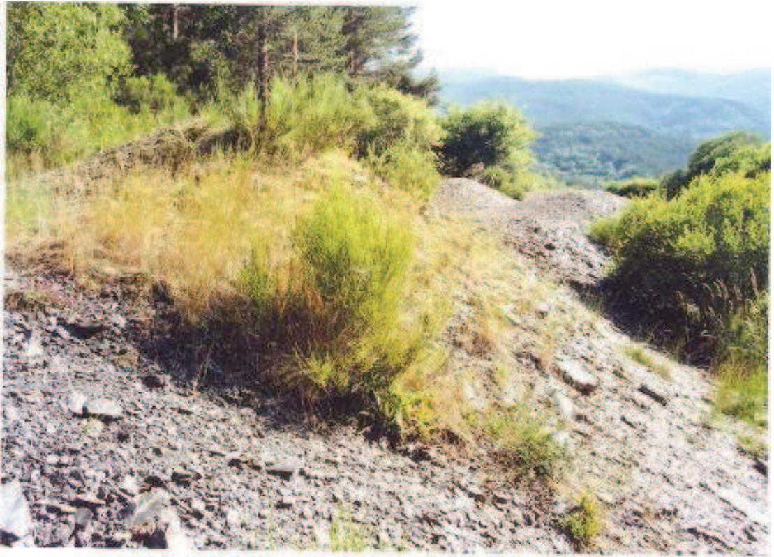
VISTA GENERAL DE LA ESCOMBRERA DE PLOMO
