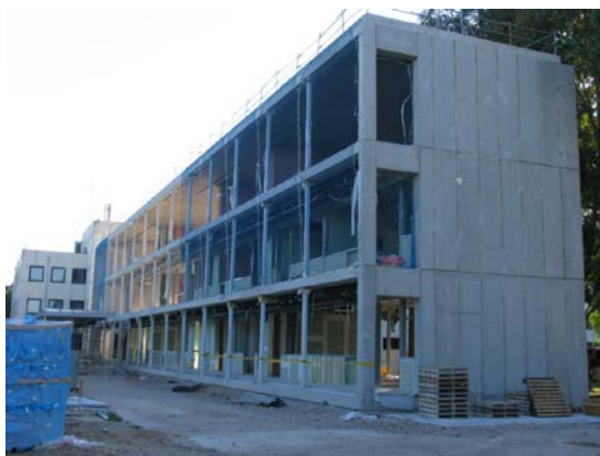
Fig1. Estado actual del CIBA.
