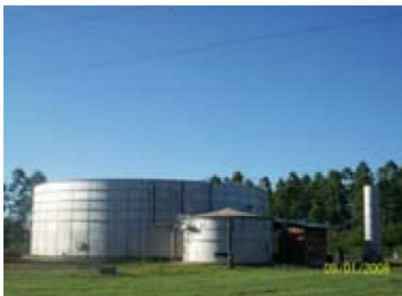
Figura 8.29. Vista del reactor UASB industrial (1).
