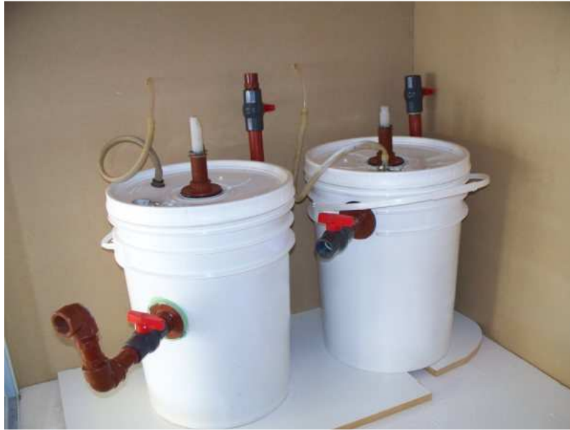
Figura 7.10. Reactores ubicados en el gabinete termostatzado.
