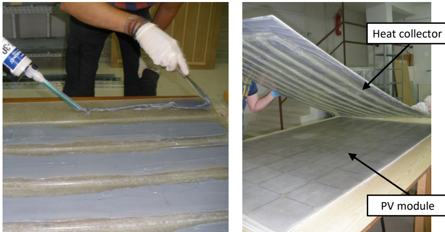
Figura II.17: Aplicación del adhesivo Crestabond M1-30 sobre el colector térmico (izquierda) y de pegado al panel fotovoltaico (derecha).
