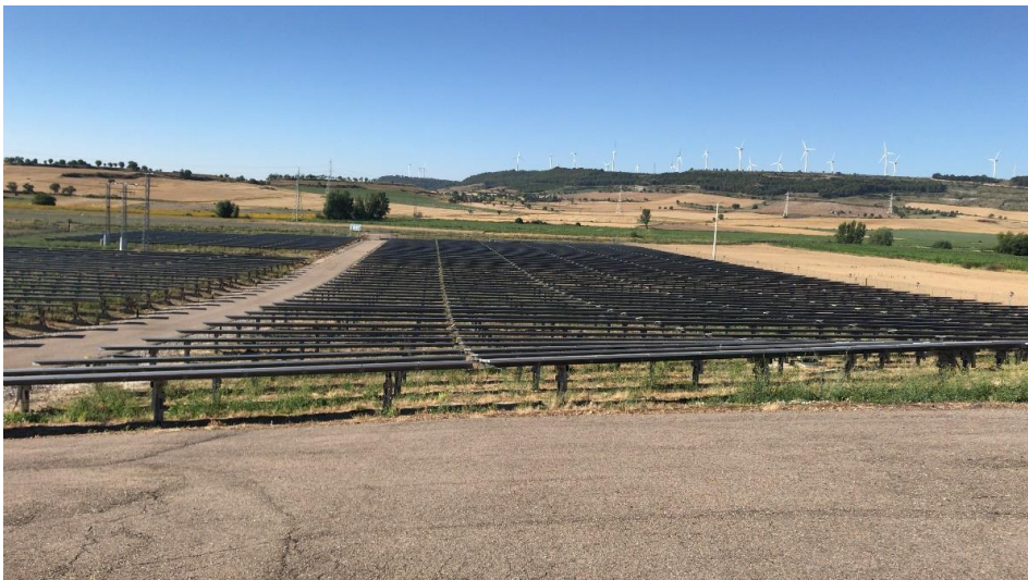
Figura III.33: Parcela donde se ha emplazado la instalación de pruebas de prototipos.
