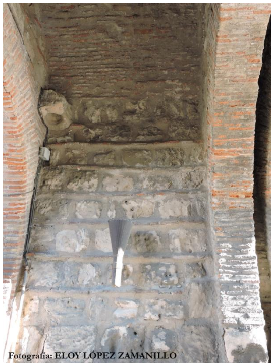
Figura 95: Aparejo toledano del “Tipo A” en paramento interior izquierdo de la Puerta de San Martín . Burgos.
