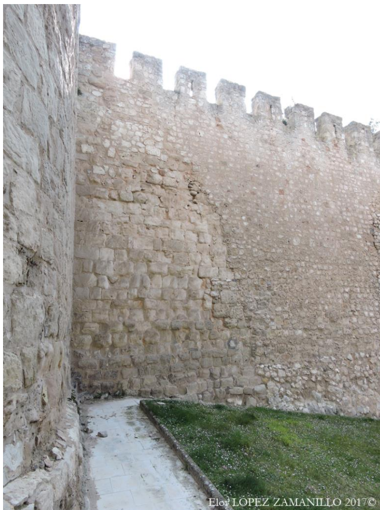
Figura 111: Encuentro entre dos tipologías constructivas diferentes de muralla junto a Puerta de San Martín , Burgos.
