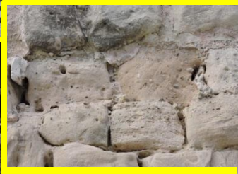
Lienzo muralla de Burgos en calle de San Esteban. Sillarejos de conglomerado principalmente colocados a tizón. < 50%
