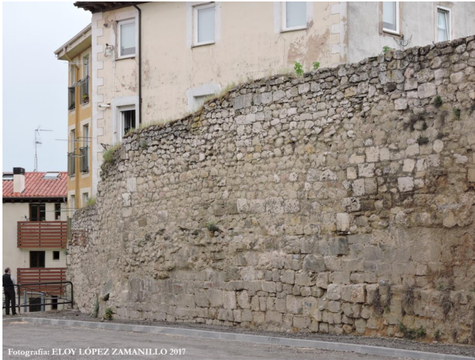
Figura 109: Tramo de muralla con sillería ciclópea caliza en calle de las Corazas , Burgos.
