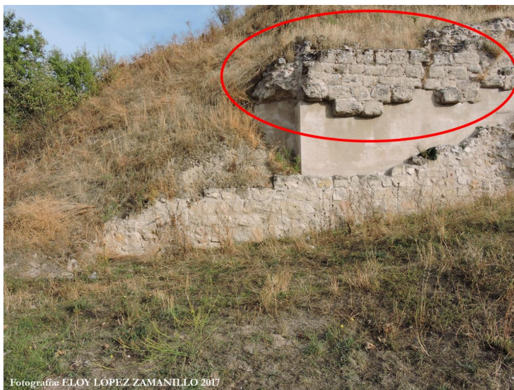
Figura 108: Restos de sillería de piedra conglomerado o rudita tipo pudinga en muros de antigua alcazaba burgalesa, calle de las Murallas nº 21, Burgos.
