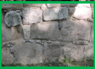
Castillo de Burgos. Dos hiladas lienzo oeste de sillarejos de conglomerado a soga y tizón. < 1%.
