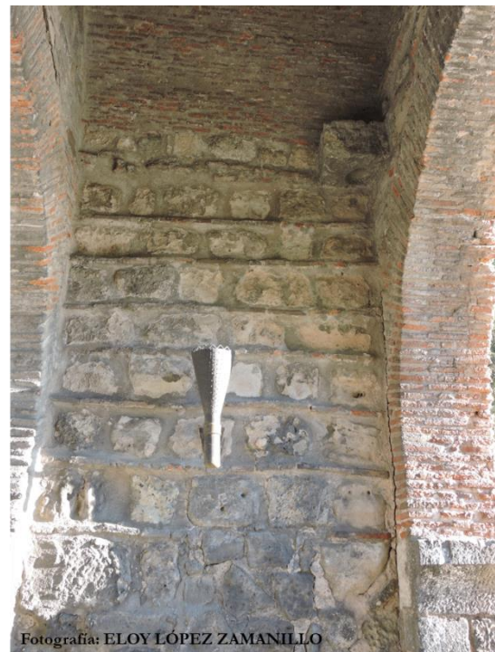
Figura 95: Aparejo toledano del “Tipo A” en paramento interior izquierdo de la Puerta de San Martín . Burgos.
