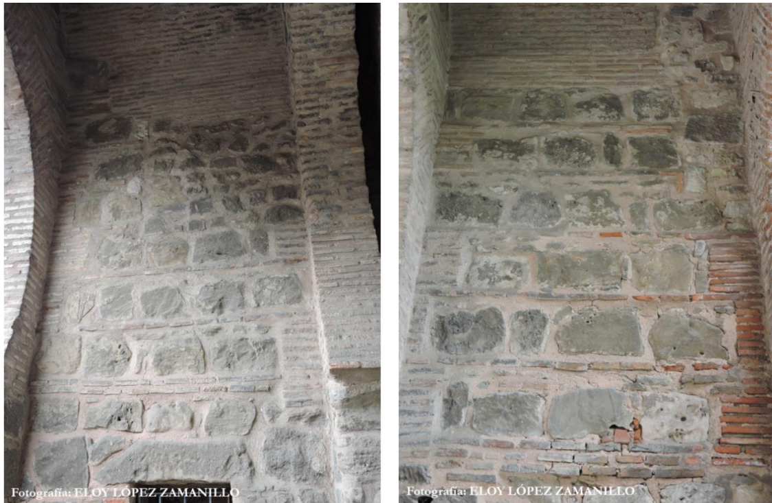
Figura 103: Aparejo toledano "Tipo A1" en paramento interior derecho de la Puerta de San Esteban . Burgos.
