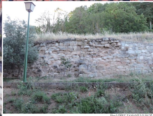
Muro de contención calzada romana
