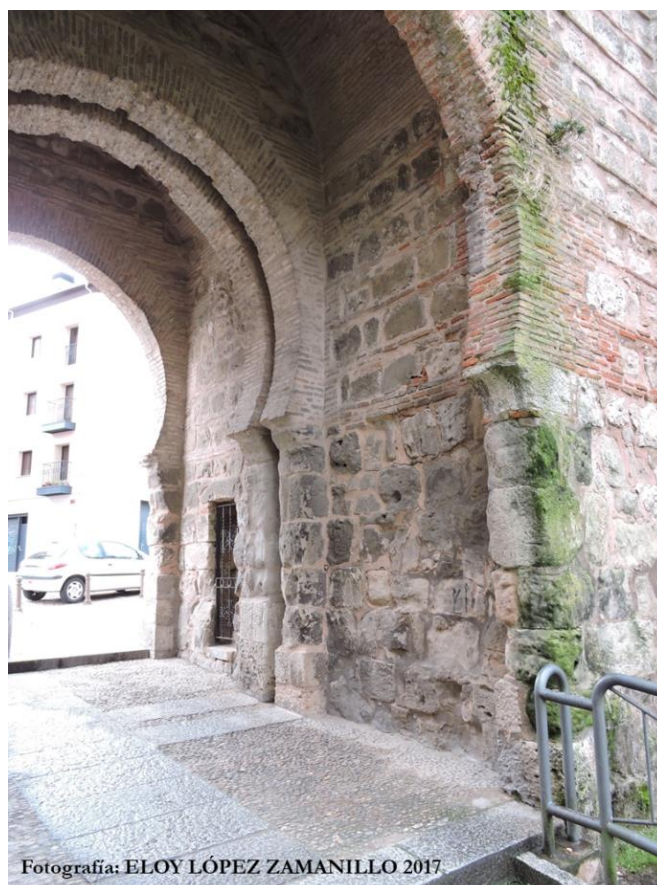
Figura 104: Interior de la Puerta de San Esteban , Burgos.
