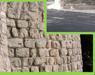
Cubo de Doña Lambra. Paseo de Los Cubos, murallas de Burgos. Sillarejos a soga y a tizón de conglomerado. Casi el 100%
