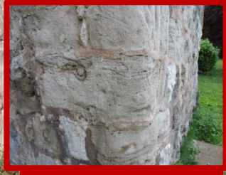
Arco de San Esteban. Sillarejos de conglomerado. <60-80%
