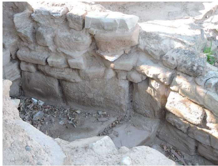
Figura 31: Empleo de mortero terroso entre los sillarejos de canal de desagüe sito en "Conjunto Termal" del yacimiento romano de "La Clínica", Calahorra (La Rioja).
