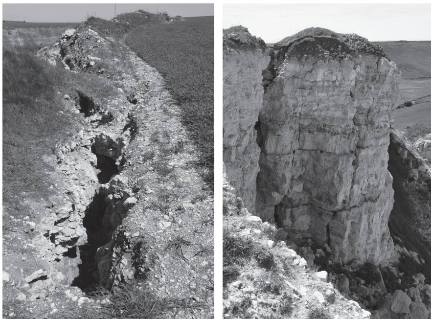
Fig. 9. Nuevas grietas de tracción se abren en la cabecera del escarpe y grandes masas rocosas se están independizando del mismo, anunciando su más que inmediata inestabilización.
