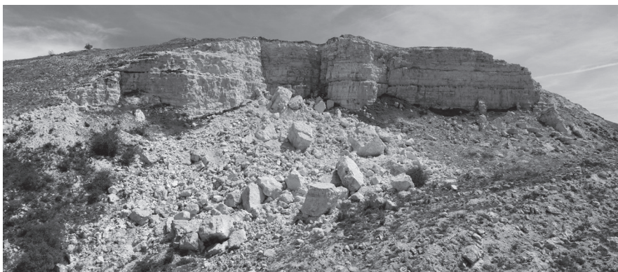
Fig. 8. Vista frontal del escarpe del deslizamiento de Ros, de 30 m de altura, y derrubios del desprendimiento rocoso reciente, originado en los primeros años del 2000, por inestabilización y retroceso del talud.
