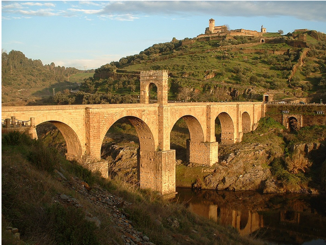
Figura 3.9: Puente de Alcántara (Cáceres).
