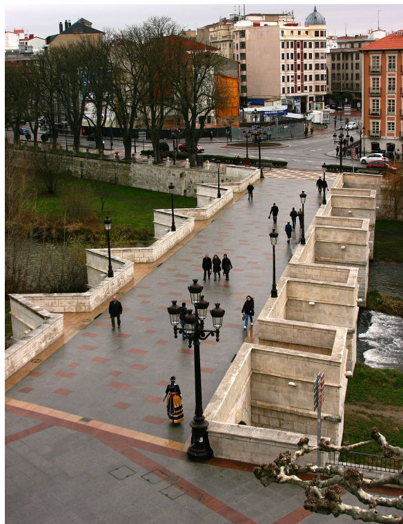
Figura 3.13: Puente de Santa María (Burgos). Se pueden apreciar los tajamares triangulares y rectangulares.
