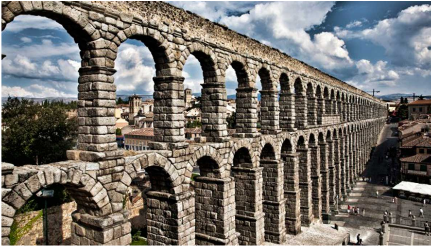
Figura 3.3: Acueducto de Segovia.
