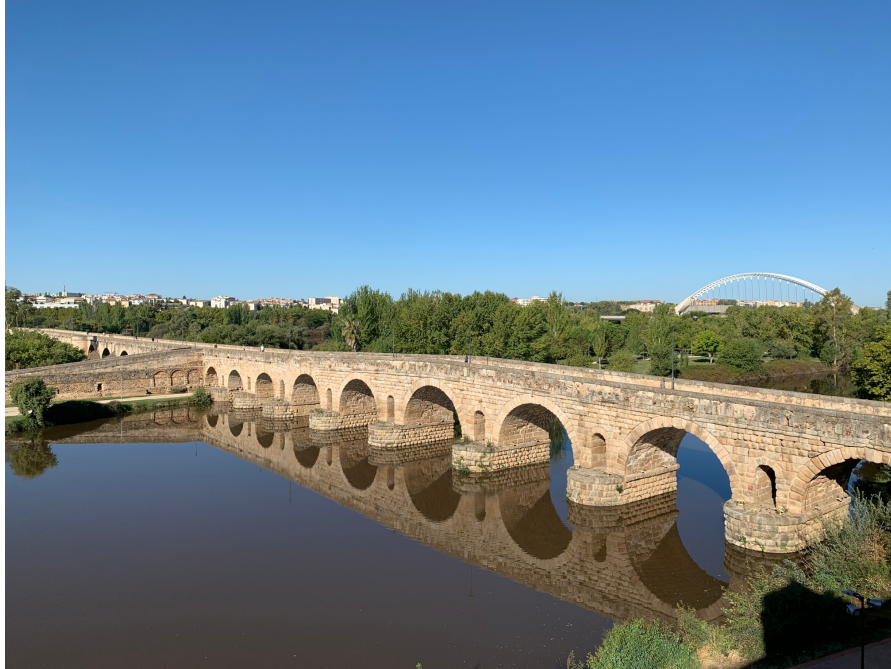
Figura 3.8: Puente de Mérida.
