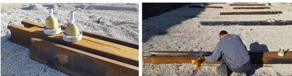
Figura 5. Plantilla de RIOMETAL recortada y colocación en cruzamiento
