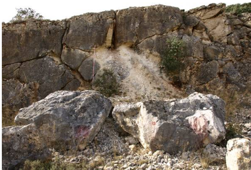
Figura 4.33 Relleno CR7 localizado en el frente de la Cantera Dura (escala 2m) (Fotografía: A. I. Ortega)
