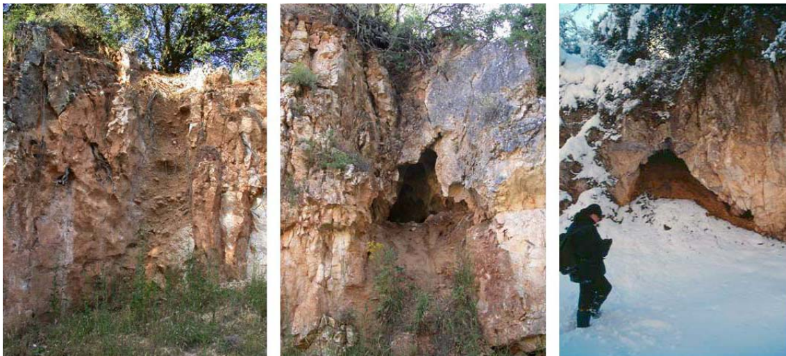
Figura 4.192 Cortes de Trinchera TR 9, 10 y 11, respectivamente, situados al norte del Valle de la Propiedad (Fotografías: A. I. Ortega y M. C. Ortega)
