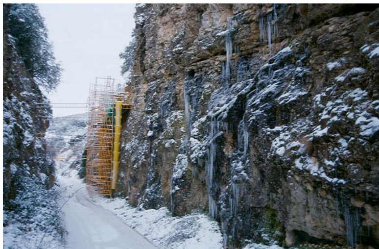
Figura 2.4 Trinchera del Ferrocarril Minero en invierno (Fotografía: A. I. Ortega)
