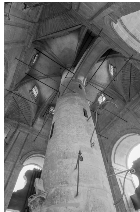
Fig. 9. Torre de la Catedral de Murcia, interior del cuerpo de campanas (Fotografía M. Saura).
