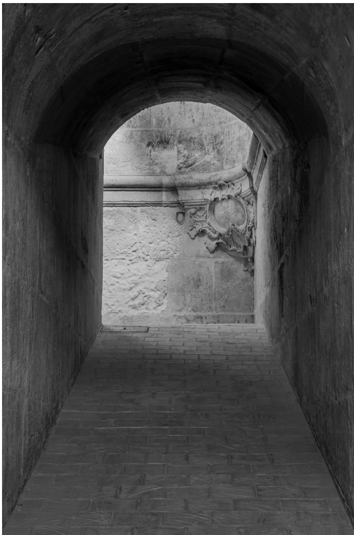
Fig. 8. Torre de la Catedral de Murcia, rampa de ascenso (Fotografía M. Saura).
