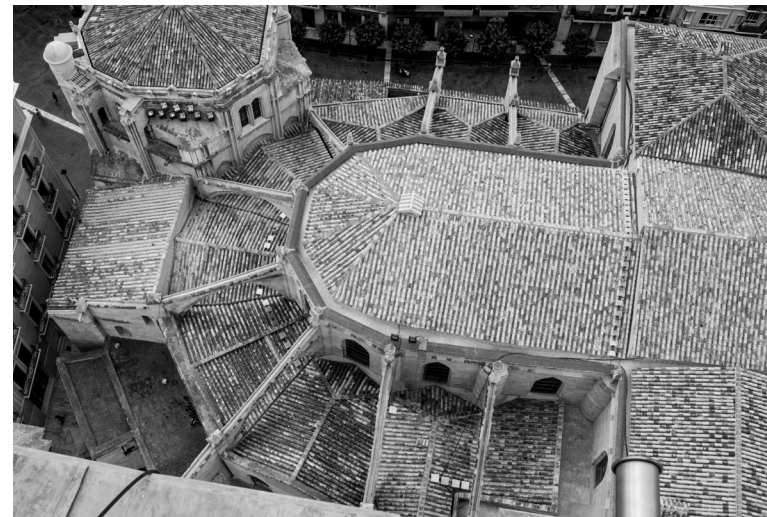
Fig. 15. Vista desde la torre de las cubiertas de la cabecera de la catedral, con la Capilla de los Vélez y el crucero (Fotografía M. Saura).
