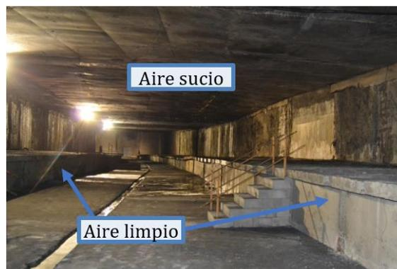
Figura 2. Imagen de la galería de ventilación, en la que se indican los conductos de entrada de aire limpio.
