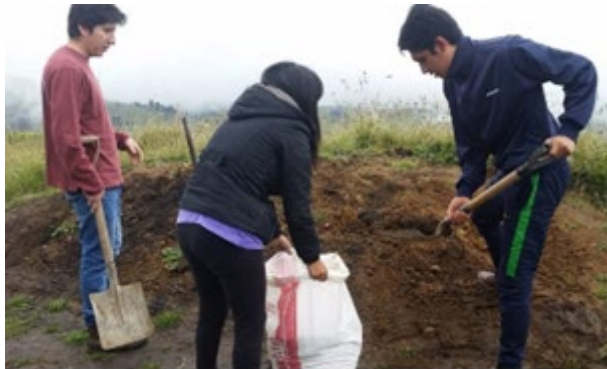
Figura 3.9 Obtención de la tierra para elaborar los bloques de adobe, Fuente: Elaboración Propia
