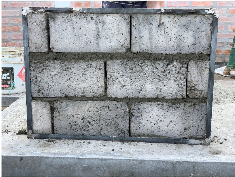
Figura 3.18 Paredes de bloque, Fuente: Elaboración Propia
