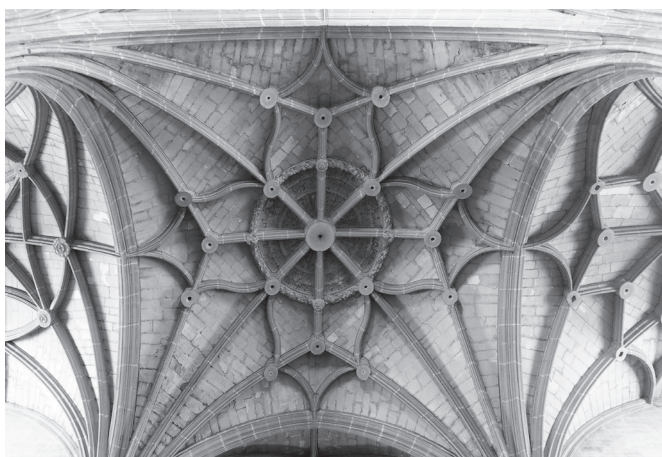
▲ Figura 56 Bóvedas de la iglesia de Pampliega (Burgos). JUAN DE VALLEJO.
