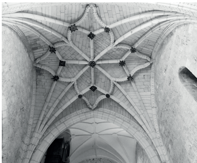
▲ Figura 2 Bóveda de hacia 1500 de la iglesia de Arcos de la Llana (Burgos).
