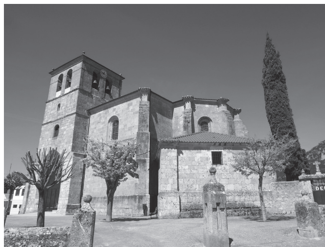
▲ Figura 48 Iglesia de Miraveche (Burgos).
