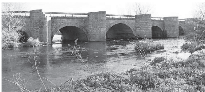
▲ Figura 6 Puente de Tardajos (Burgos).
