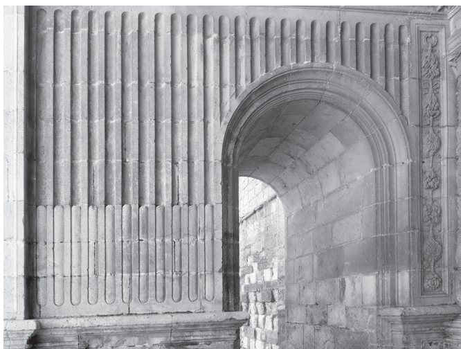
▲ Figura 10 Detalle de la zona inferior de la torre de Santa María del Campo (Burgos). DIEGO DE SILOE.
