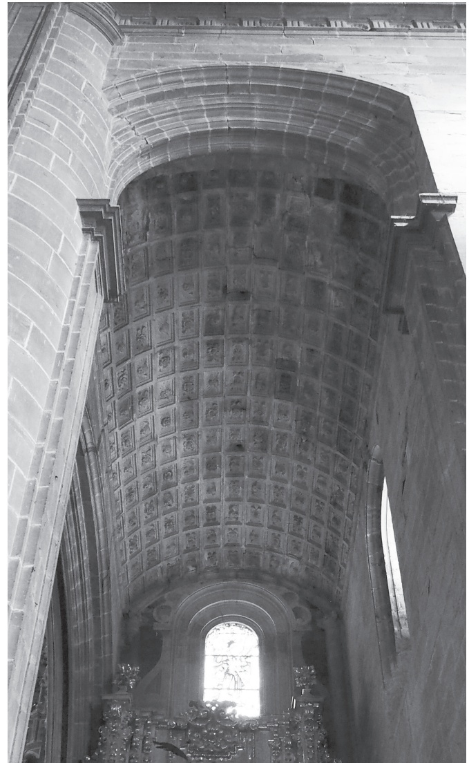
▲ Figura 60 Bóvedas de la iglesia de Navarrete (Burgos). JUAN DE VALLEJO.
