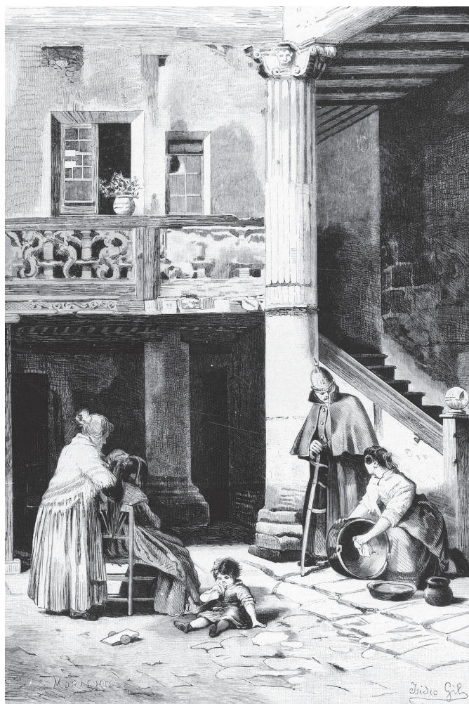
▲ Figura 18 Patio de la casa de los Cubos de Burgos.
