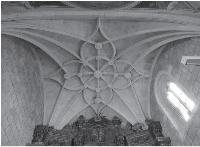
▲ Figura 24 Bóveda del presbiterio de la iglesia de Villagonzalo Pedernales (Burgos).
