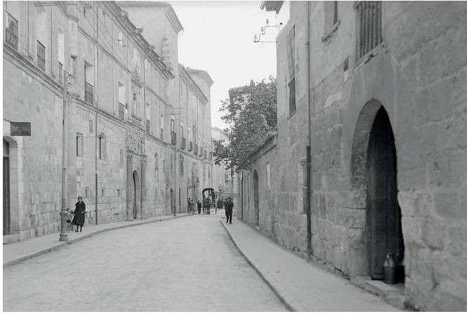
▲ Figura 8 Casas de la Calle de la Calera de Burgos.
