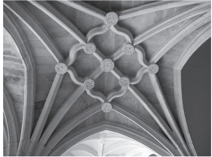
▲ Figura 26 Bóveda del claustro del antiguo Convento de San Agustín de Burgos.
