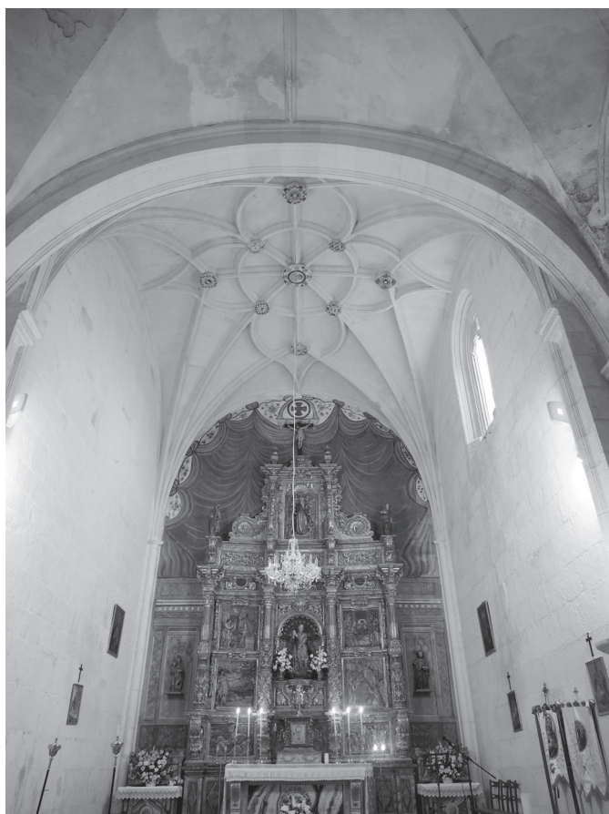
▲ Figura 31 Interior de la iglesia de Cubillo del Campo (Burgos). Bóveda del presbiterio.
