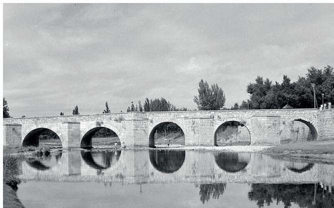
▲ Figura 4 Puente de Malatos de Burgos.
