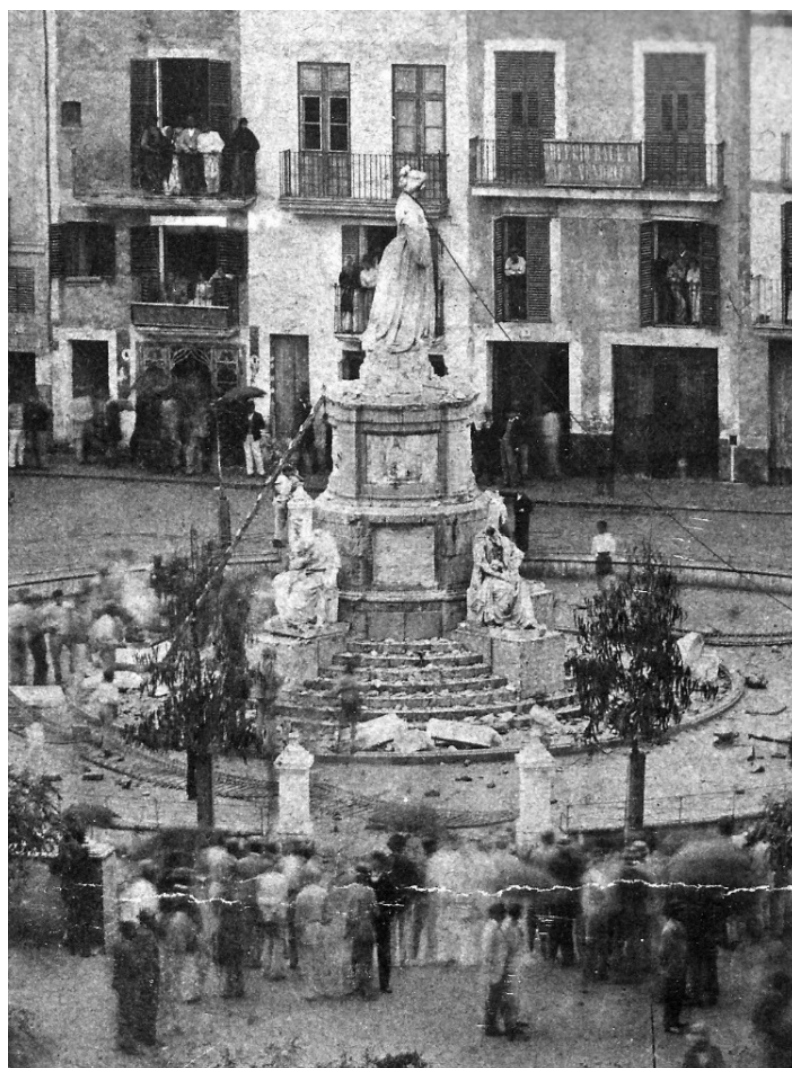
Figura 5.- Un grupo “derroca” la estatua de Isabel II con una soga en Palma de Mallorca
