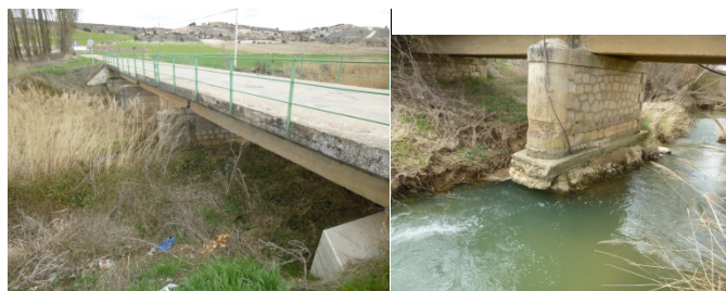
Figura 01: Estado original de los puentes de Casanova y Cuzcurrita (Burgos).
