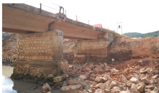
Figura 05: Pila descalzada
