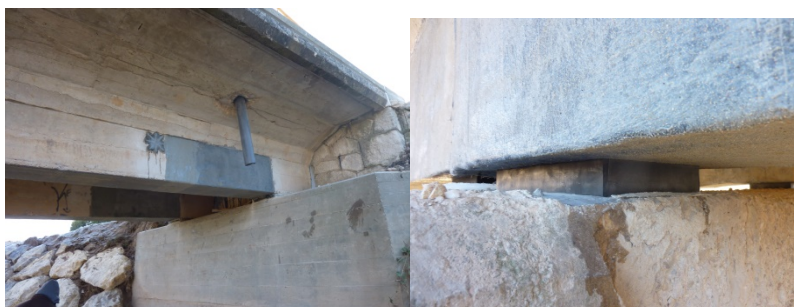
Figura 08: Refuerzo a cortante, anclaje con cordón y apoyo.
